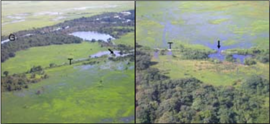
FIGURA 21. Izquierda: Aguas del caño Guarítico (G) que han desbordado el terraplén (T). Derecha: Aguas del caño Caicara que también has desbordado el terraplén y corren hacia la sabana (T). Fotos Rafael Antelo.
