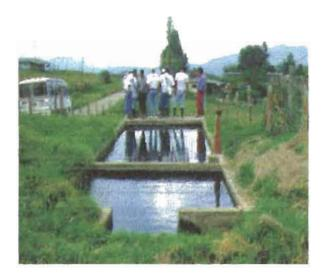
El desarenador es un tanque que generalmente tiene tres cámaras. En la primera cámara de llegada, se encuentra el vertedero de excesos, el cual permite que el agua sobrante pueda volver a la fuente de agua.
