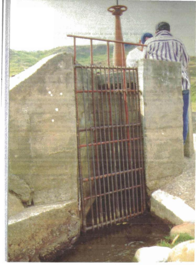
La bocatoma es una estructura hidráulica con la cual se capta y deriva el agua de una comiente superficial permanente hacia el sistema de riego.
