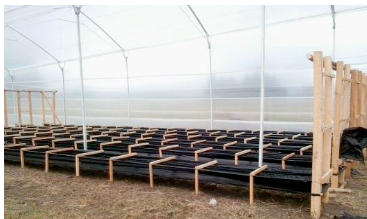
Figura 2. Vista general de las naves del invernadero tradicional con estructura metálica (a) y de las camas de cultivo construidas para el ensayo, en el lote 5 del CAM.
