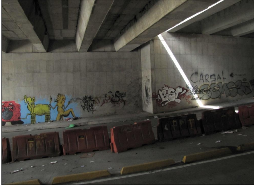
Figura 21. Túnel en Av. El Dorado. Nathaly Díaz. Noviembre de 2013
