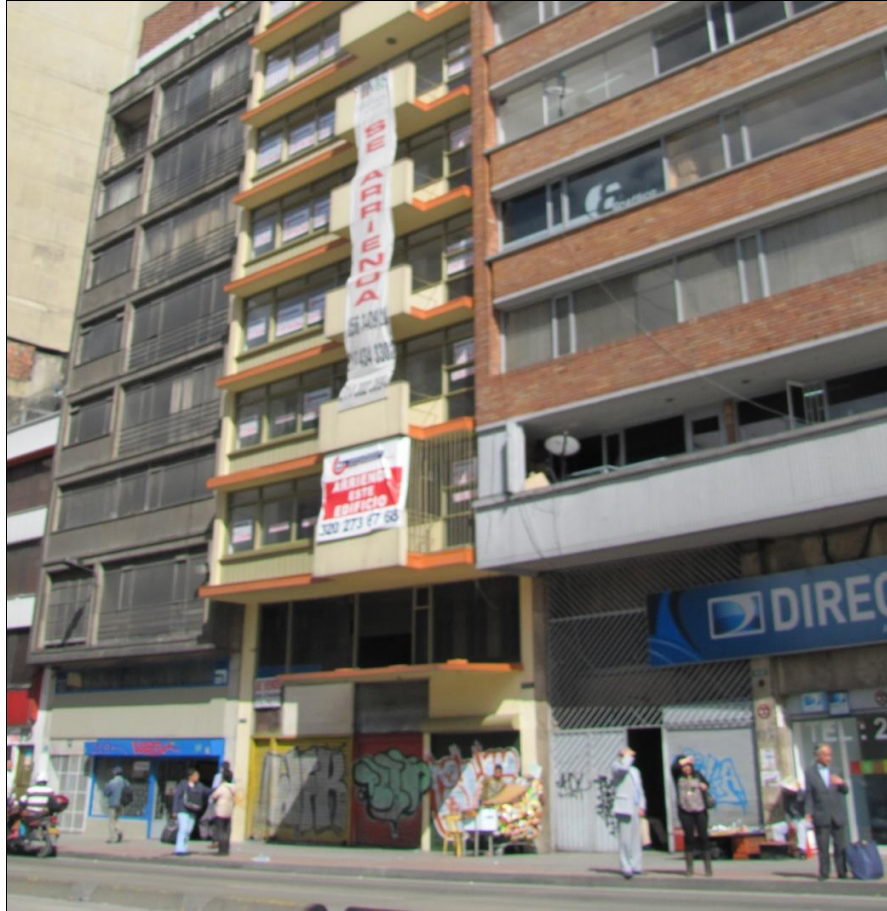
Figura 16. Edificio subutilizado en Av. Fdo. Mazuera. Nataly Díaz. Octubre 2014
