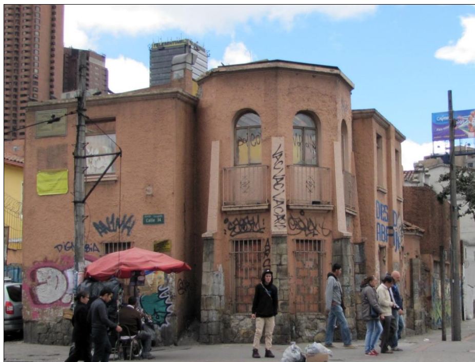
Figura 23. Casa de influencia europea en proyecto de demolición. Avenida Caracas con calle 34. Esquina Sur. Nataly Díaz. Octubre de 2014.
