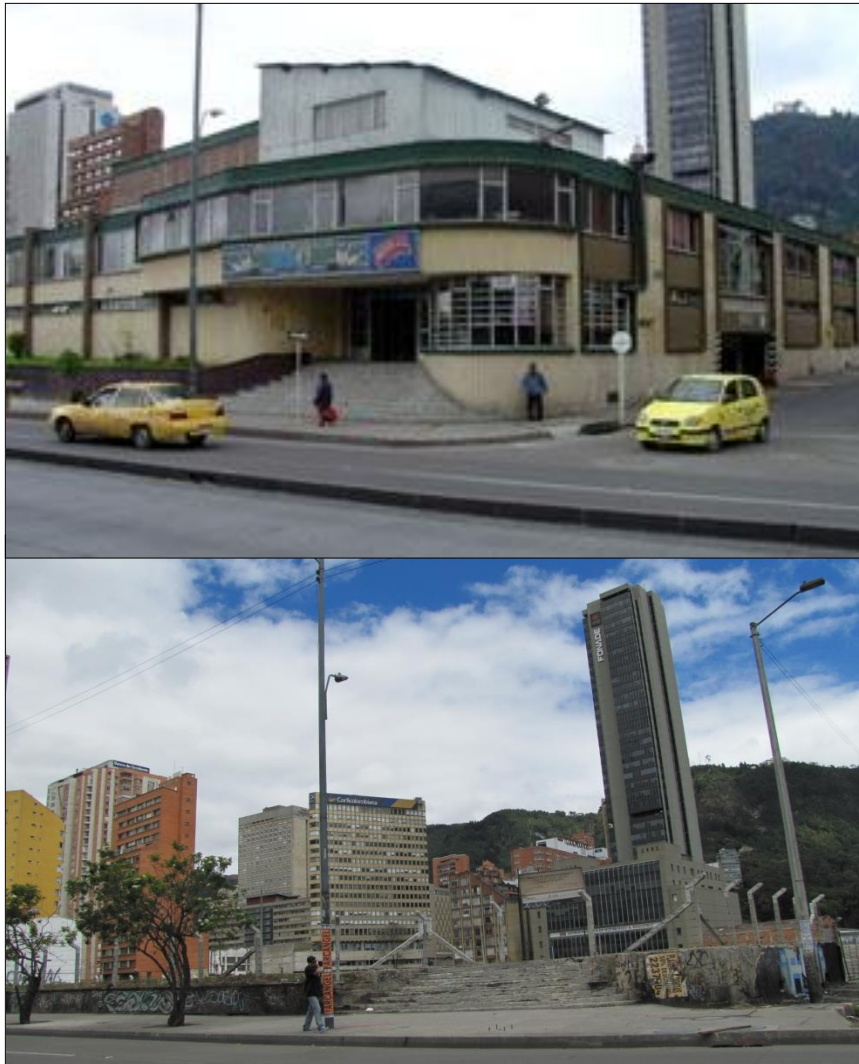
Figuras 30 y 31. Esquina Av. Caracas con calle 24. Antes y después del proceso de demolición. Omar Ducuara, 2010 y Nataly Díaz, 2014.
