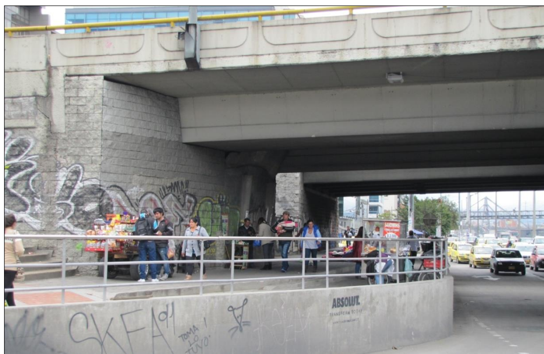
Figura 13. Puente vehicular con venta informal. Avenida NQS. Nataly Díaz. 2014
