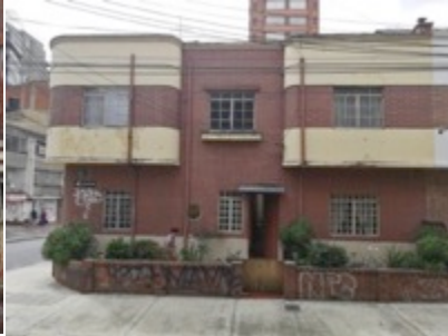
Ilustración 143. Casa en la carrera 8a con calle 42.
