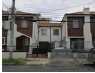
Ilustración 325. Vista de dos casas construidas a la par, con un lenguaje que combina elementos que provienen del estilo Tudor y elementos modernistas.
