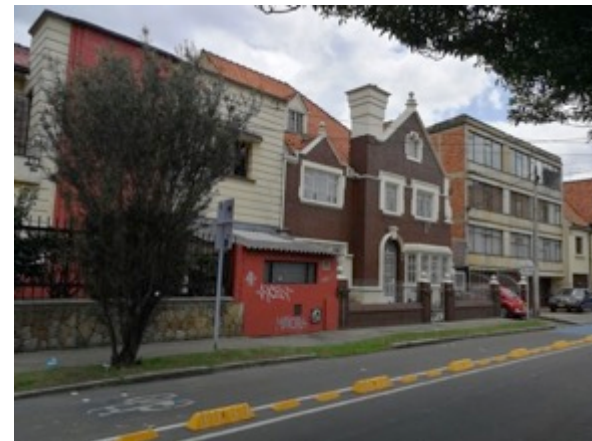
Ilustración 432. Vista del costado oriental de la transversal 16 bis entre diagonal 46 y 45F.
