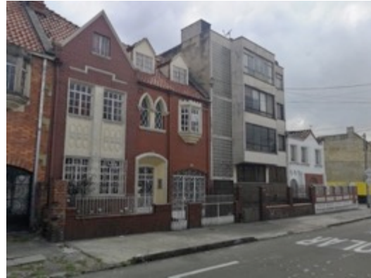
Ilustración 430. Vista del costado sur de la diagonal 48 entre transversales 16 bis y 16 B.
