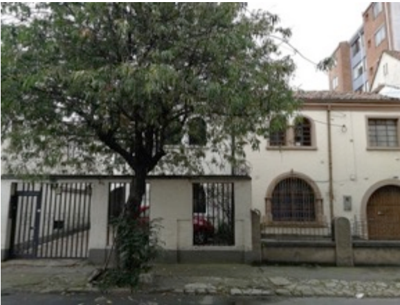
Ilustración 397. Edificación localizada en la Transversal 16 Bis No. 45 D - 74.
