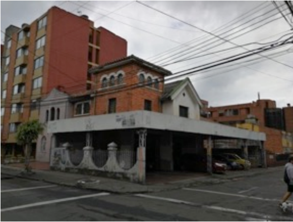
Ilustración 399. Edificación localizada en transversal 16 Bis No. 45 D - 79.
