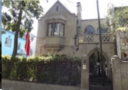
Ilustración 304. Casa de las Gárgolas en Santiago de Chile, construida en 1929. Fuente: Anderson Sevelion, Wikimedia Commons, 2012
