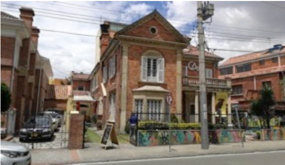
Ilustración 413. Edificación ubicada en la transversal 17 y que presenta construcción aislada.
