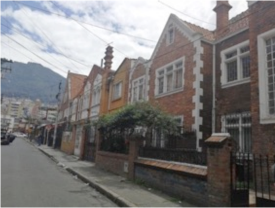
Ilustración 424. Vista del costado sur de la calle 45 A entre la avenida Caracas y la carrera 15.
