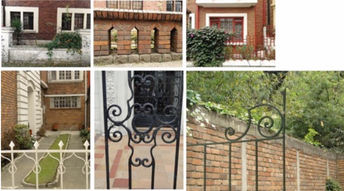
Ilustración 437. Detalles de cerramientos de antejardines que se encuentran en el barrio Palermo.
