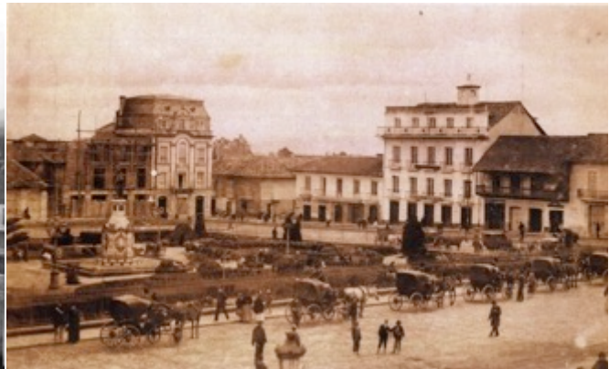
Ilustración 449. Vista del costado norte de la plaza de Bolívar, durante la construcción del Edificio Liévano. Circa. 1902. Autor: desconocido. Fuente: http://www.asisucedio.co/1903-plaza-de-bolivar/
