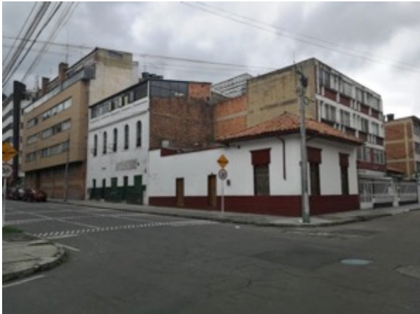
Ilustración 123. Heterogeneidad urbana en el Barrio Chapinero Norte. Carrera 9 con calle 65.
