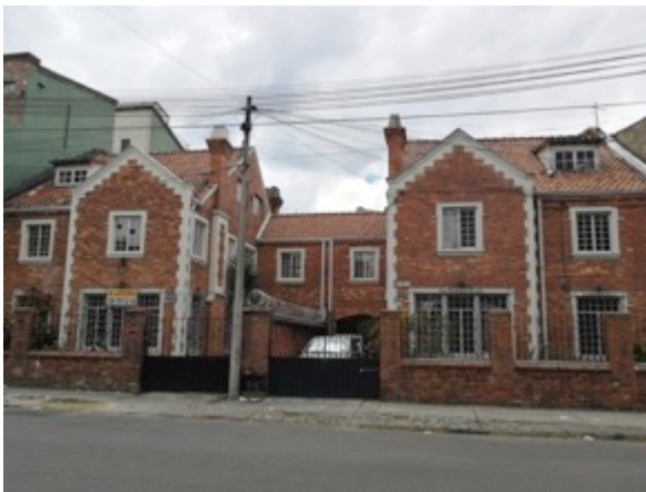
Ilustración 407. Vista del costado norte de la diagonal 48 con transversal 20.
