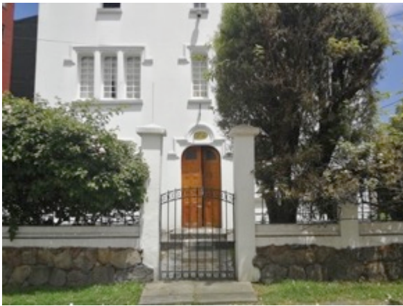
Ilustración 403. Edificación localizada en la carrera 15 No. 46 – 21.
