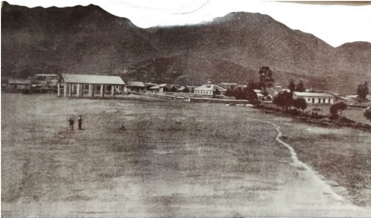
LOTES DEL " BARRIO DEL MERCADO. " PLAZA EN CONSTRUCCION
