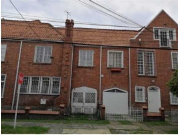
Ilustración 417. Vista del empalme de dos viviendas dispuestas en construcción continua.
