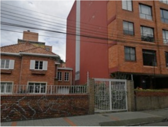
Ilustración 391. Vista de dos edificaciones colindantes en la que el edificio contemporáneo rompe con la configuración volumétrica y arquitectónica de su vecino. Ubicado en la diagonal 45 D con carrera 16.
