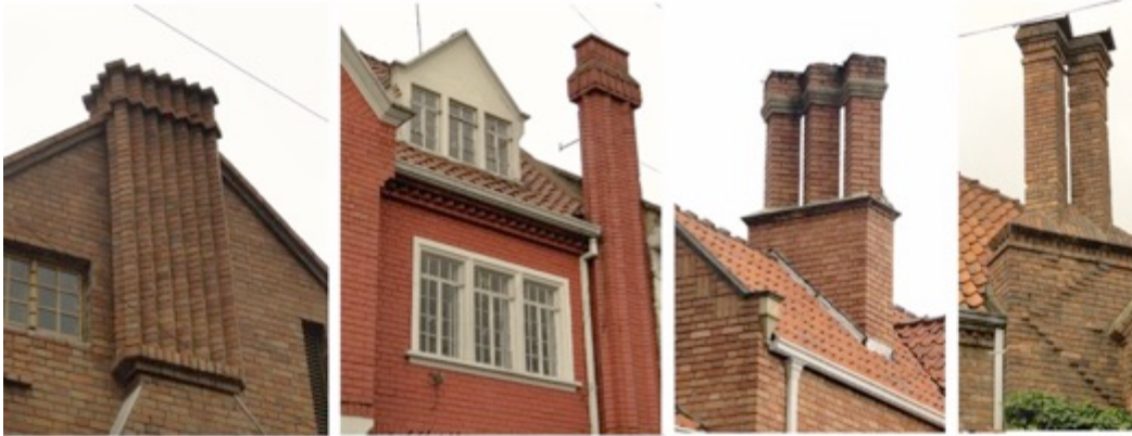
Ilustración 441. Detalles de chimeneas de viviendas en el barrio Palermo.
