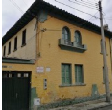
Ilustración 235. Vivienda localizada en la calle 43 a con carrera 18 A. Arquitectura de los años 1930. Arquitecto Gabriel Serrano.
