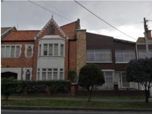
Ilustración 429. Vista del costado sur de la diagonal 46 entre las transversales 22 y 22.
