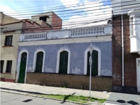
Ilustración 187. Edificación en la calle 50 con carrera 17.
