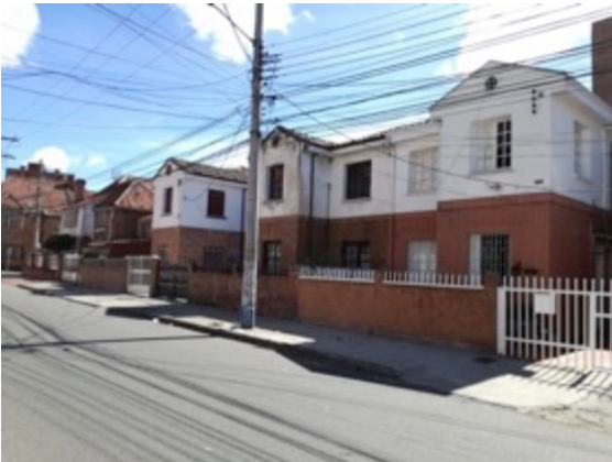
Ilustración 189. Visual del costa occidental de la carrera 16 con calle 48.
