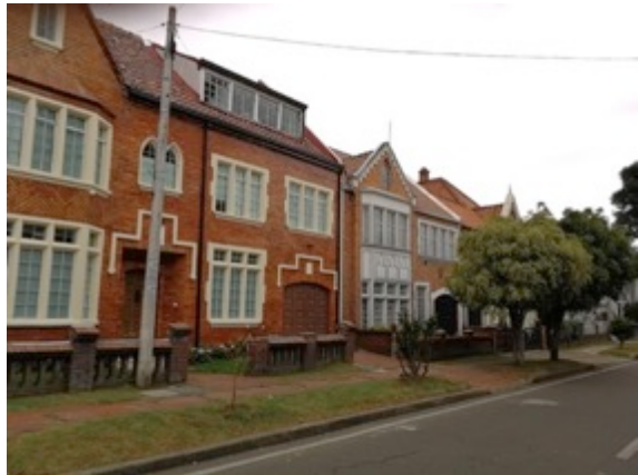
Ilustración 427. Vista del costado sur de la diagonal 46 entre las transversales 20 y 22.
