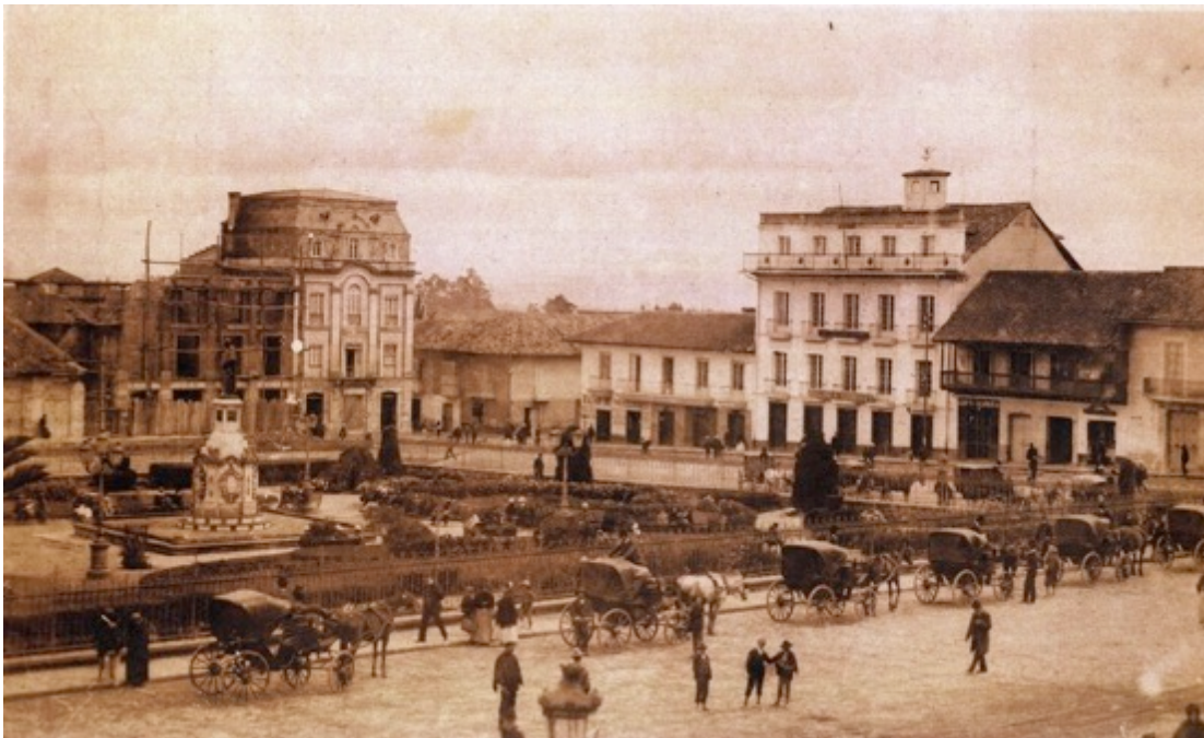
Ilustración 74. Vista del costado norte de la plaza de Bolívar, durante la construcción del Edificio Liévano. Circa. 1902. Autor: desconocido. Fuente: http://www.asisucedio.co/1903-plaza-de-bolivar/
