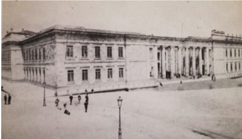
Ilustración 35. Estado del Capitolio a finales del siglo XIX donde se observa la balaustrada ejecutada por Mario Lambardi en el costado occidental del edificio y que posteriormente fue desmontada para concluir y uniformar el coronamiento de los muros del edificio. Fuente: (CORRADINE, 1998). Propiedad del Ingeniero José María de Mier y Riaño.
