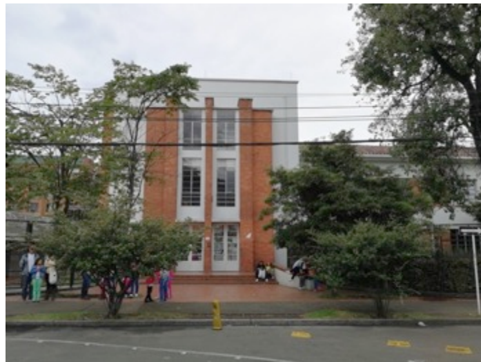
Ilustración 333. Vista del Colegio Técnico Palermo, hoy Colegio Técnico Distrital Palermo, localizado en la carrera 23 con calle 47.
