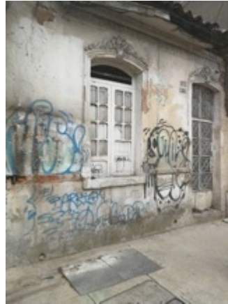
Ilustración 188. Edificación localizada en la carrera 15ª con calle 58 a
