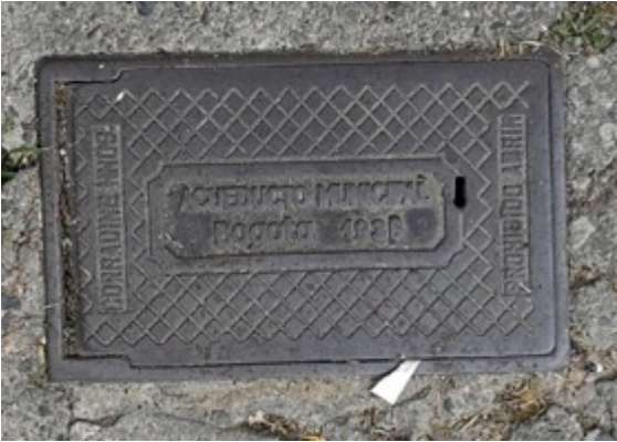
Ilustración 452. Tapa del medidor de una vivienda en el barrio Palermo
