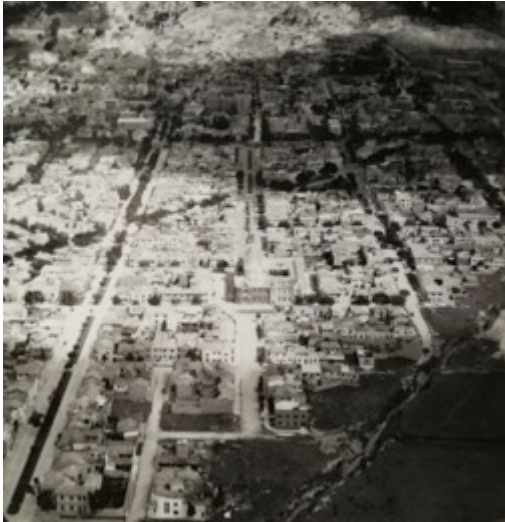
Ilustración 213. Vista aérea del barrio Santa Teresita c.c. 1947. Fuente: (MEJIA PAVONY & CUELLAR, 2007)
