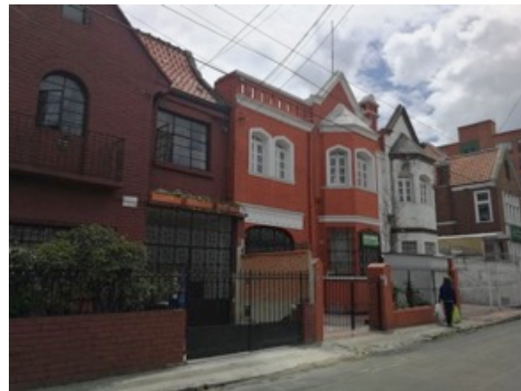
Ilustración 408. Vista del costado occidental de la carrera 14 A con calle 46.
