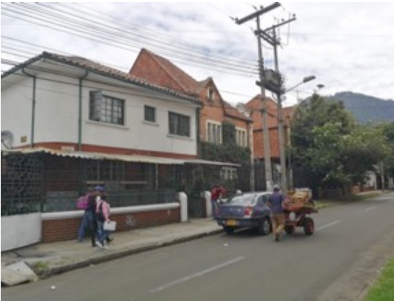
Ilustración 401. Edificación localizada en diagonal 48 No. 18 - 70.
