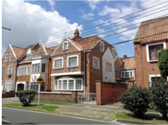
Ilustración 425. Vista del costado norte de la Diagonal 46 con transversal 17.
