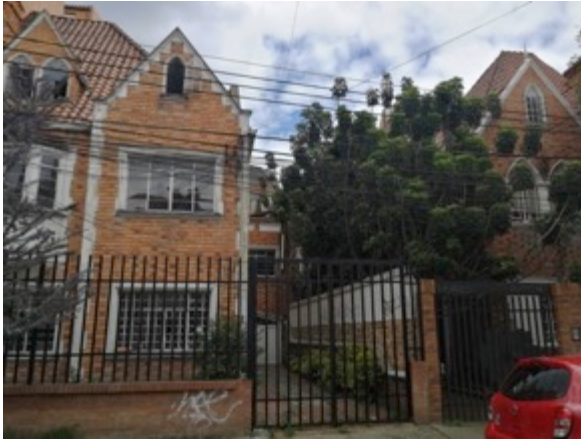
Ilustración 409. Vista del costado norte de la diagonal 46 con transversal 20.
