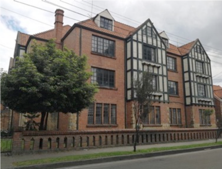
Ilustración 387. Vista del Edificio de apartamentos Arturo de Brigard.
