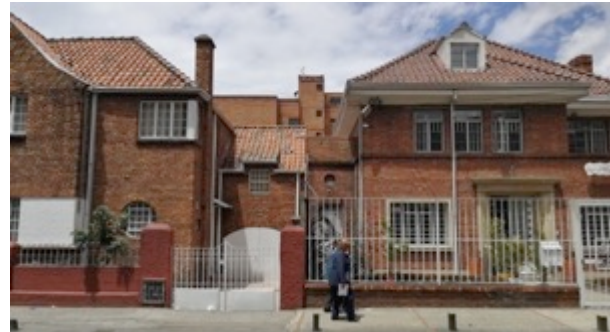
Ilustración 414. Edificación ubicada en la transversal 17 y que presenta construcción aislada.
