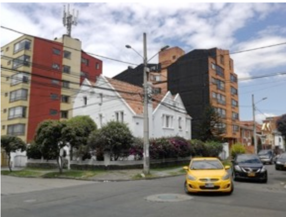
Ilustración 389. Visual de la esquina noroccidental de la diagonal 46 con carrera 15
