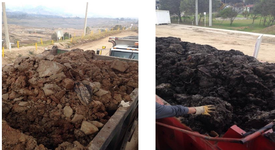
Figura 2-3: Toma de muestras de arcillas residuales de excavación.
