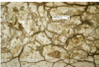
**Figura 1.** Las grietas abiertas se llenan parcialmente con carbonato de calcio en un bloque prefabricado de una chimenea. Se evidencian daños de la adherencia cíclica y de las altas
