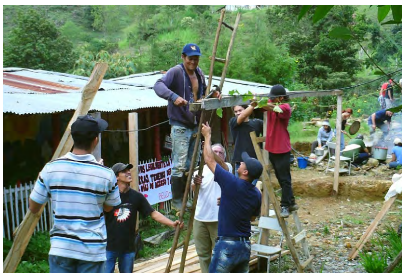
Figura 1. Construcción del aula múltiple de la Cephás, 19 de mayo de 2013
