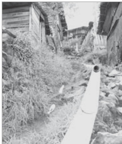
Ilustración 6. Accesos, desagües y vivienda en el barrio La Avanzada 8 .
