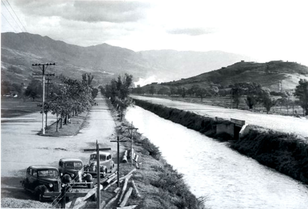
Ilustración 4. Aspecto del corredor del Río Medellín en la zona de La Macarena tras los primeros trabajos de canalización. 5
