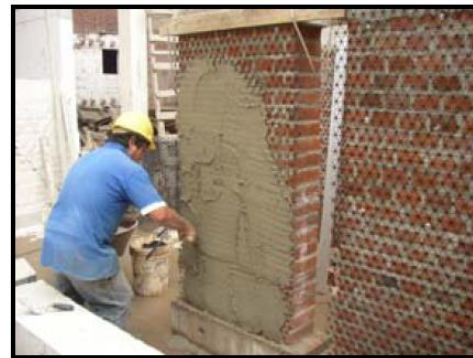
Imagen 3.2.2-1. Fijación de la malla de polímero; Imagen 3.2.2-2. Reforzamientos con malla de polímero y pañete. Fuente: TORREALVA, D. Refuerzo de muros y tabiques de albañilería con mallas de polímero. Pontificia Universidad Católica del Perú. [En línea] 2007. Disponible en web: < http://blog.pucp.edu.pe/media/688/20071017-Torrealva-Polimero.pdf >.
