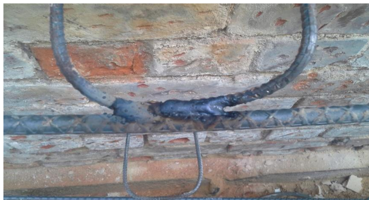
Imagen 6.3.9., Soldadura del estribo a la varilla. Fuente Imagen propia
