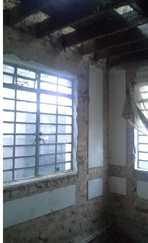
Imágenes 6.3.1. y 6.3.2 , demolición de pañetes en mal estado, afectados por la humedad (imagen del lado izquierdo) y . Preparación de las superficies de contacto de las láminas de acero, con el corte y demolición del pañete. Fuente Imágenes propias
