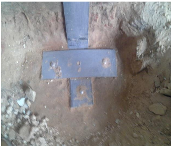
Imágenes 6.3.3. y 6.3.4 , anclaje de las láminas de acero a la cimentación de la edificación (imagen del lado izquierdo) y . anclaje químico del perno de acero, en el cruce de dos platinas . Fuente Imágenes propias
