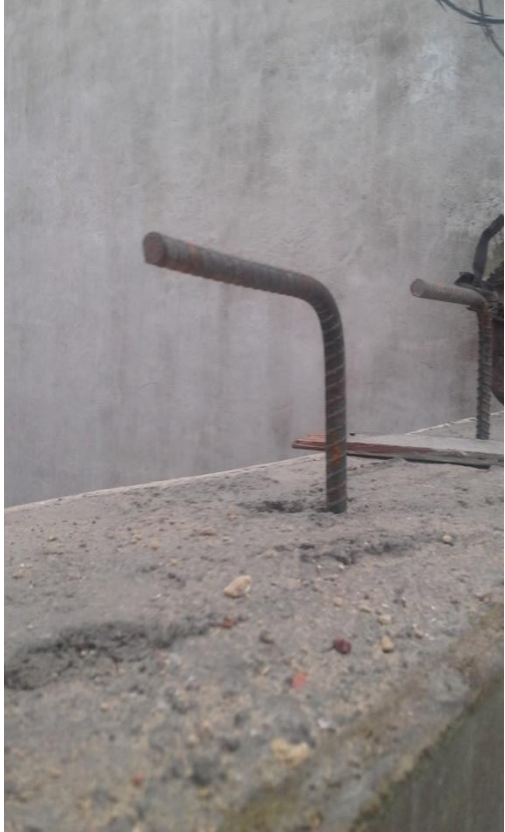
Imágenes 6.3.16 y 6.3.17 Anclaje químico de varillas, en L, con adhesivo epóxico (imagen de la izquierda) y , amarre de la canasta de acero con las varillas el L, respectivamente. Fuente Imágenes propias
