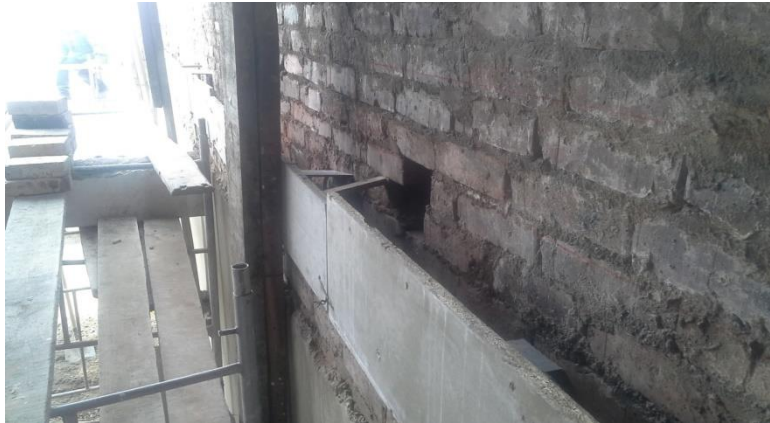
Imagen 6.3.20, Instalación de la formaleta de madera. Fuente Imagen propia
