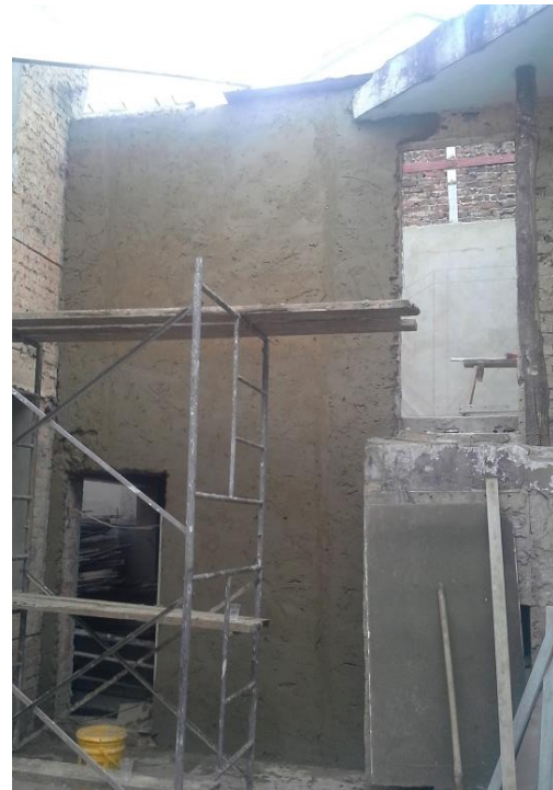
Imágenes 6.3.23 y 6.3.24 Amarre de malla metálica con vena, sobre, las láminas metálicas (imagen de la izquierda) y , pañete sobre los muros reforzados, respectivamente. Fuente Imágenes propias
