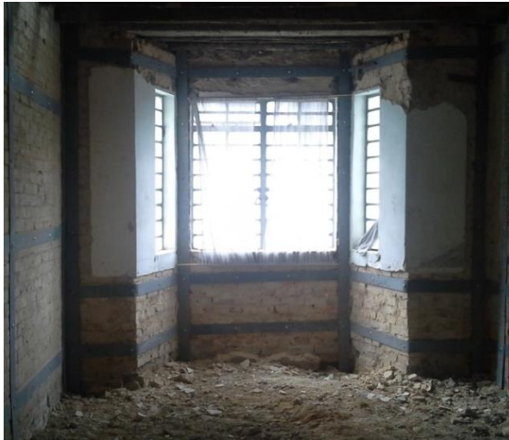
Imágenes 6.3.5 y 6.3.6. Instalación de las láminas de acero en los muros de las fachadas principal y lateral, respectivamente. Fuente Imágenes propias
