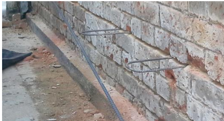
Imagen 6.3.8. perforaciones para colocar los estribos de acero abiertos. Fuente Imagen propia
