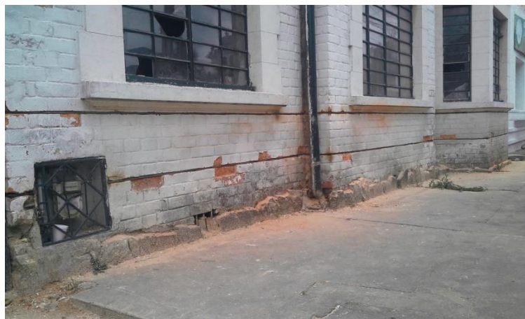
Imagen 6.3.12. Instalación simultánea de los estribos abiertos, a través de las perforaciones y de las varillas, en las ranuras longitudinales, en la fachada principal. Fuente Imagen propia
