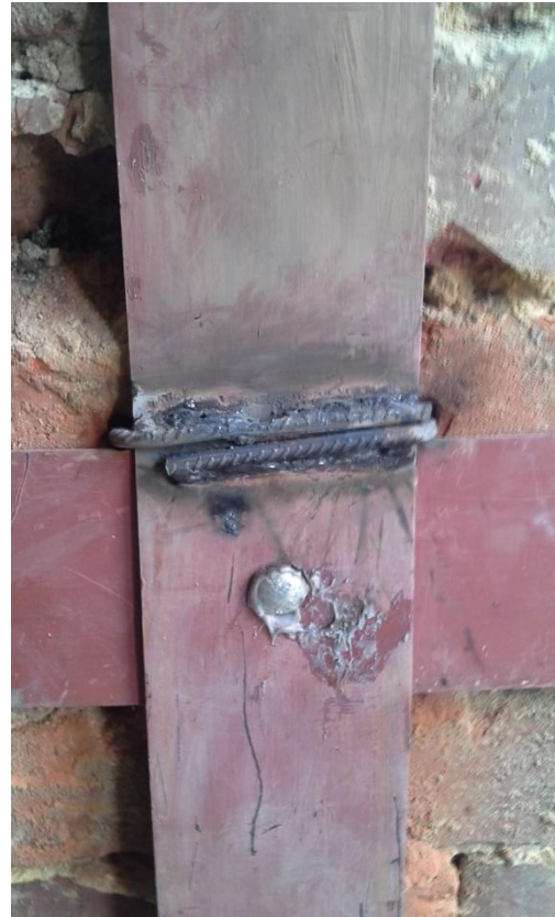
Imágenes 6.3.13 y 6.3.14 Doblaje de los estribos, amarando las platinas, ubicadas al interior de los muros y Soldadura de un estribo a las platinas, respectivamente. Fuente Imágenes propias
