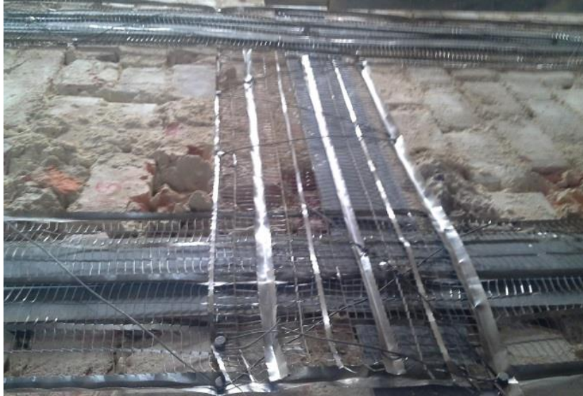
Imagen 6.3.22, Amarre de malla metálica con vena, sobre, las láminas metálicas. Fuente Imagen propia
