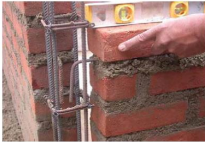
Imagen 3.4.1-1. Detalle del armado del acero de refuerzo; Imagen 3.4.1-2. Vista general del módulo B. Fuente: PÉREZ, J., ENCISO, J y QUIUN, D. Ensayos de Simulación Sísmica de Modelos de Albañilería Confinada. Pontificia Universidad Católica del Perú. [En línea] 2009. Disponible en web: < http://blog.pucp.edu.pe/media/688/20091111-PEREZ-ENCISO-QUIUN-Ensayos%20alba%20conf.pdf >.
