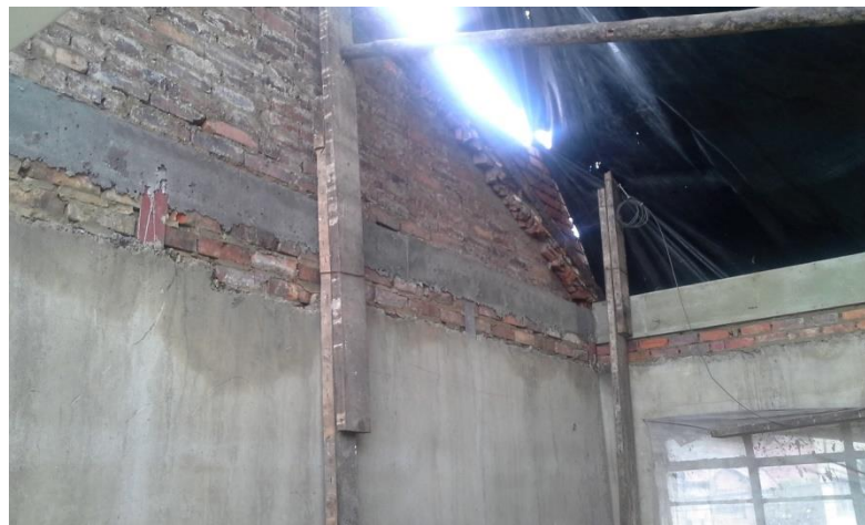
Imagen 6.3.21, Fundida de la viga de coronamiento del muro. Fuente Imagen propia
