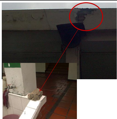
Imagen de desprendimiento de pañetes de una canal a nivel de cubierta. Fuente: Consorcio TDF
