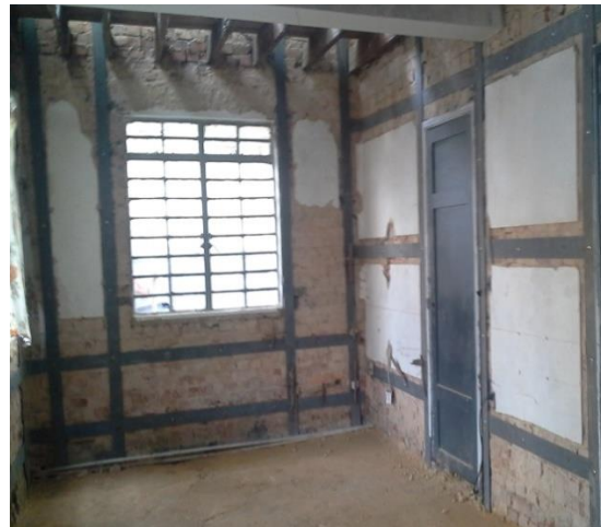
Imágenes 6.3.5 y 6.3.6. Instalación de las láminas de acero en los muros de las fachadas principal y lateral, respectivamente. Fuente Imágenes propias
