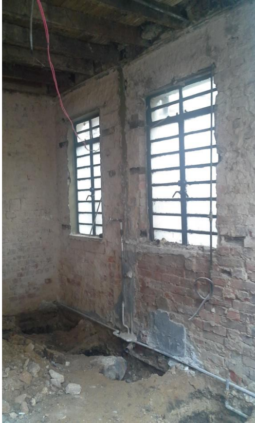
Imágenes 6.3.1. y 6.3.2 , demolición de pañetes en mal estado, afectados por la humedad (imagen del lado izquierdo) y . Preparación de las superficies de contacto de las láminas de acero, con el corte y demolición del pañete. Fuente Imágenes propias
