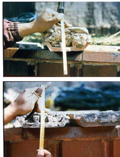
Imagen de los enchapes y mortero de pega. Fuente: Proyectistas Civiles Asociados- PCA
