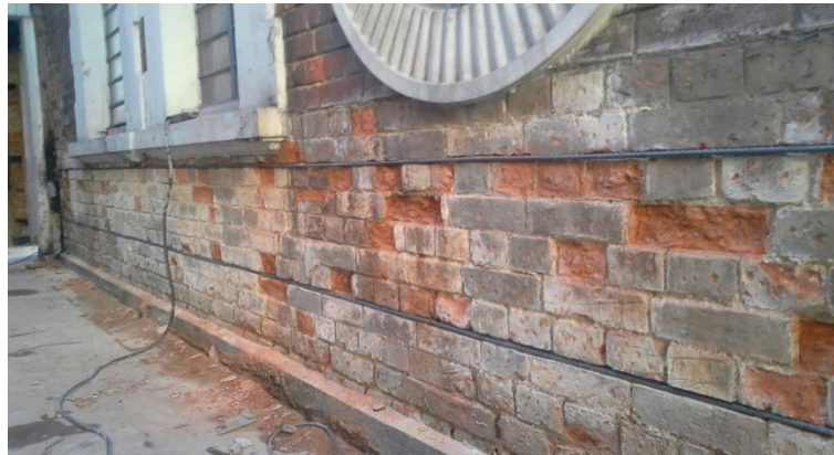
Imagen 6.3.11. Instalación simultánea de los estribos abiertos, a través de las perforaciones y de las varillas, en las ranuras longitudinales, en la fachada lateral. Fuente Imagen propia
