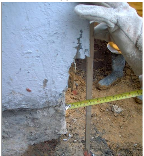
Imagen del desprendimiento y espesor de los pañetes en una columna. Fuente: Consorcio TDF
