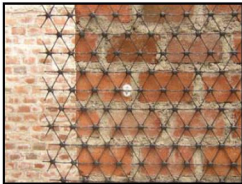
Imagen 3.2.2-1. Fijación de la malla de polímero; Imagen 3.2.2-2. Reforzamientos con malla de polímero y pañete. Fuente: TORREALVA, D. Refuerzo de muros y tabiques de albañilería con mallas de polímero. Pontificia Universidad Católica del Perú. [En línea] 2007. Disponible en web: < http://blog.pucp.edu.pe/media/688/20071017-Torrealva-Polimero.pdf >.
