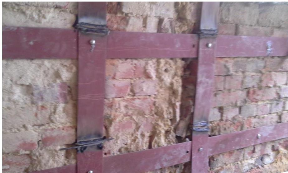
Imagen 6.3.15, Soldadura de los estribos a las platinas. Fuente Imagen propia
