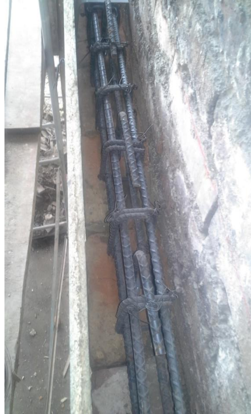
Imágenes 6.3.16 y 6.3.17 Anclaje químico de varillas, en L, con adhesivo epóxico (imagen de la izquierda) y , amarre de la canasta de acero con las varillas el L, respectivamente. Fuente Imágenes propias
