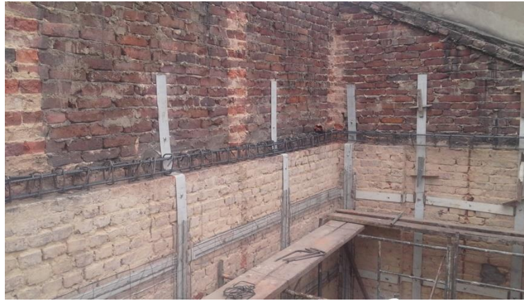
Imagen 6.3.19, Soldadura de las láminas de acero a la armadura de la viga. Fuente Imagen propia
