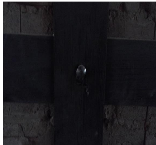
Imágenes 6.3.3. y 6.3.4 , anclaje de las láminas de acero a la cimentación de la edificación (imagen del lado izquierdo) y . anclaje químico del perno de acero, en el cruce de dos platinas . Fuente Imágenes propias
