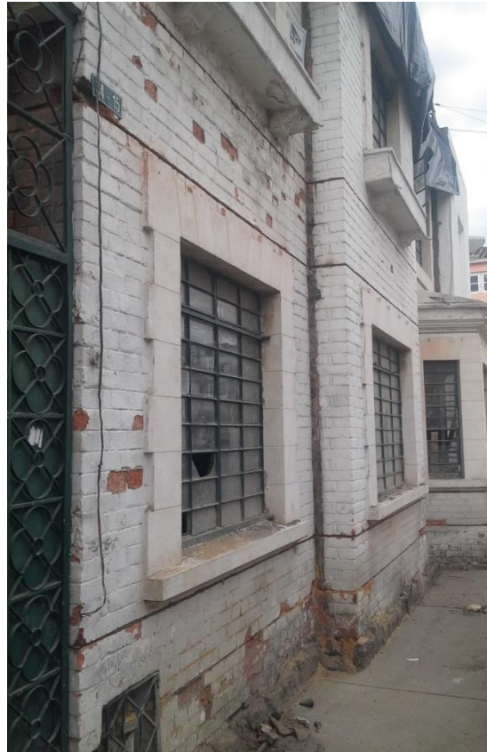
Imágenes 6.5.1. y 6.5.2 , estado de los muros de la fachada principal, luego del sismo del 10 de marzo de 2015 . Fuente Imágenes propias
