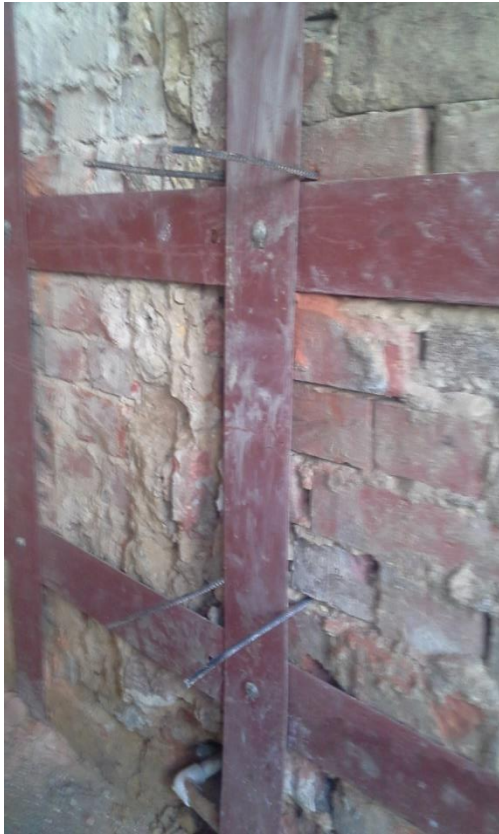
Imágenes 6.3.13 y 6.3.14 Doblaje de los estribos, amarando las platinas, ubicadas al interior de los muros y Soldadura de un estribo a las platinas, respectivamente. Fuente Imágenes propias
