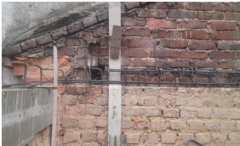
Imagen 6.3.18, amarre de la canasta de acero con las varillas el L. Fuente Imagen propia
