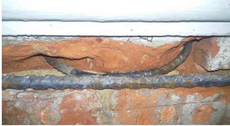
Imagen 6.3.10. Instalación simultánea de los estribos abiertos, a través de las perforaciones y de las varillas, en las ranuras longitudinales. Fuente Imagen propia
