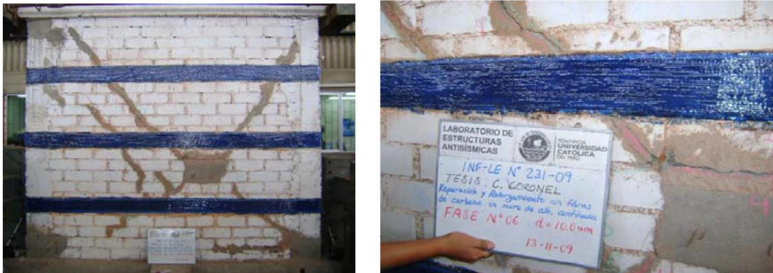
Imagen 3.1.1-1. Rehabilitación de muro con láminas FCPR. Imagen 3.1.1-2. Detalle de la rehabilitación de muro con láminas FCPR Fuente: SAN BARTOLOMÉ, A. y CORONEL, C. Reforzamiento de un muro de albañilería confinada mediante fibra de carbono. Pontificia Universidad Católica del Perú . [En línea] 2011. Disponible en web: < http://blog.pucp.edu.pe/media/688/20110805-Reparacion-fibra%20de%20carbono.pdf >.
