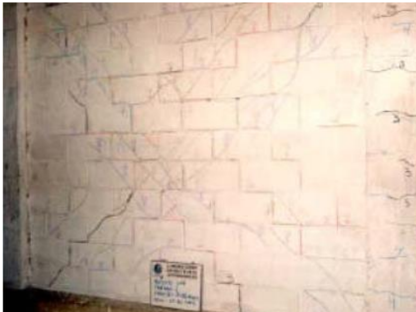
La imagen 3.1.2-1. Fisuración del murete IM2 luego del ensayo de carga lateral cíclica coplanar. Fuente: TUMIALAN, G., NANNI, A. y SAN BARTOLOMÉ, A. Comportamiento sísmico de tabiques reforzados con varillas de fibra de vidrio. Pontificia Universidad Católica del Perú . [En línea] 2002. Disponible en web: < http://blog.pucp.edu.pe/media/688/20070427-URM%20Infills-Varillas%20de%20fibra%20de%20vidrio.pdf >.
