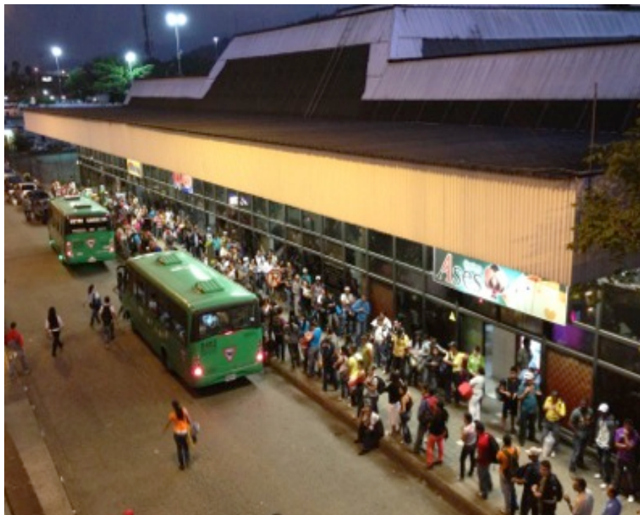
Terminal de transporte del Norte, contigua a la estación Caribe del Metro de Medellín. Fotografía: autor
