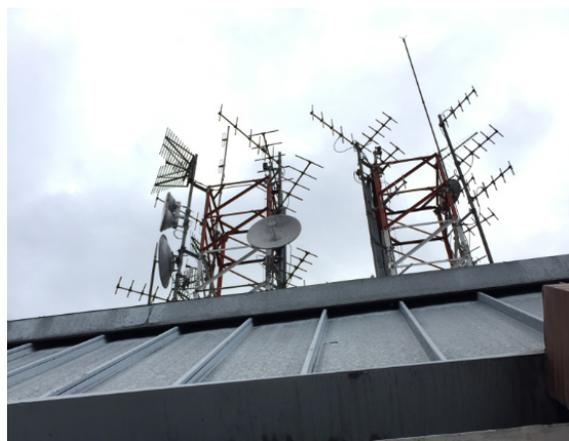
(e) Antena de microondas
