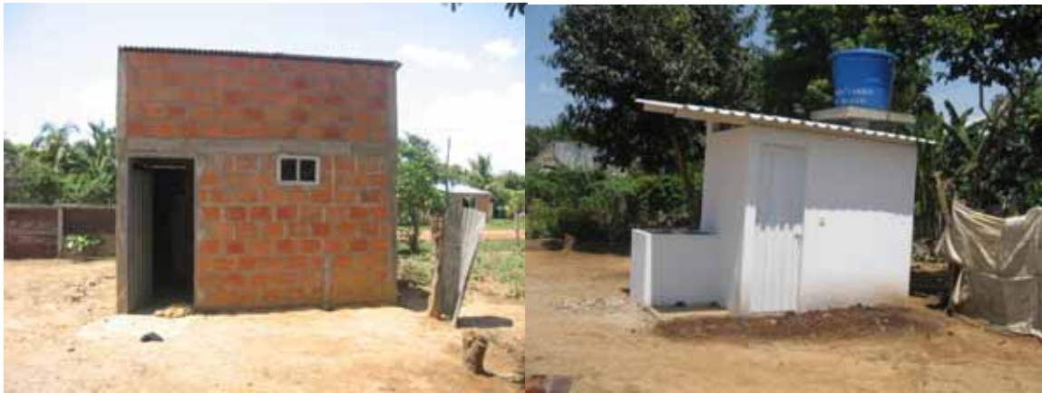
Fotos 46-47: Fachada, lavadero y baño del proyecto de vivienda etnia Cuiba
