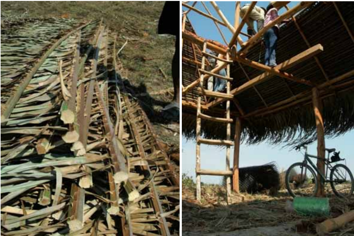
Foto 7-8: Armado de la cubierta de la vivienda tradicional Sáliba
