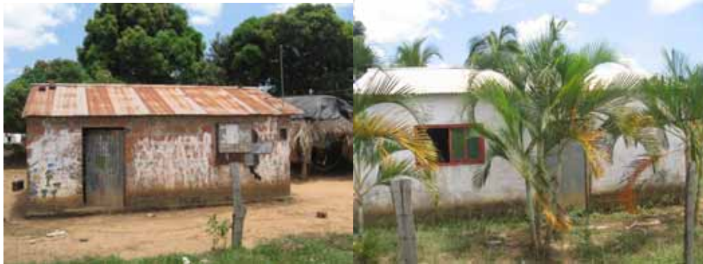
Fotos 36-37: Proyecto de mejoramiento de vivienda etnia Sikuani
