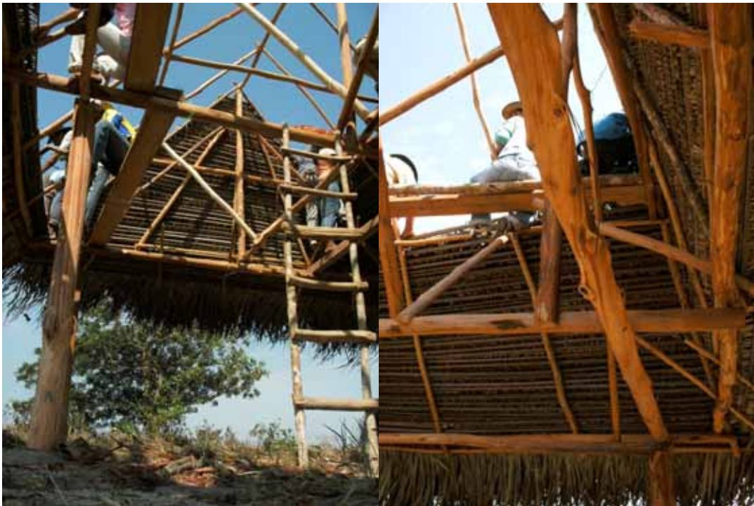
Foto: 3-4: Estructura de la vivienda tradicional Saliba
