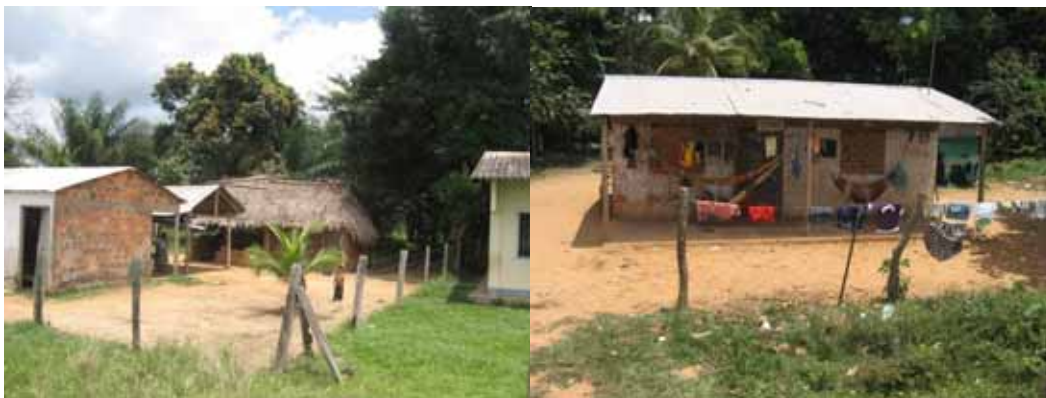
Fotos 38-39: Proyecto de mejoramiento de vivienda etnia Sikuani.
