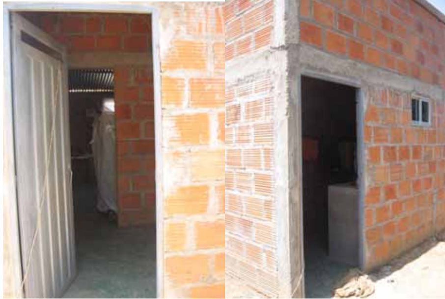
Fotos 50-51: Acceso y cocina del proyecto de vivienda etnia Cuiba
