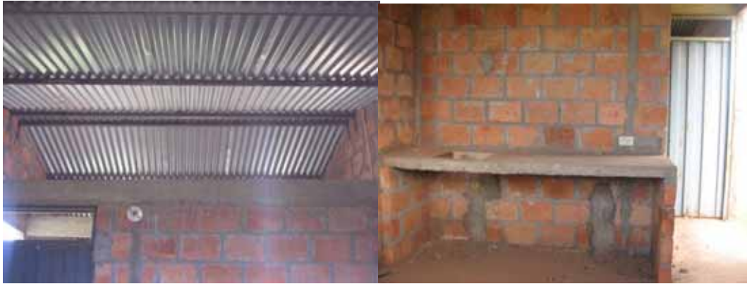
Foto 62-63: Cubierta y cocina del proyecto VISR. Villa Adriana Primavera Vichada
