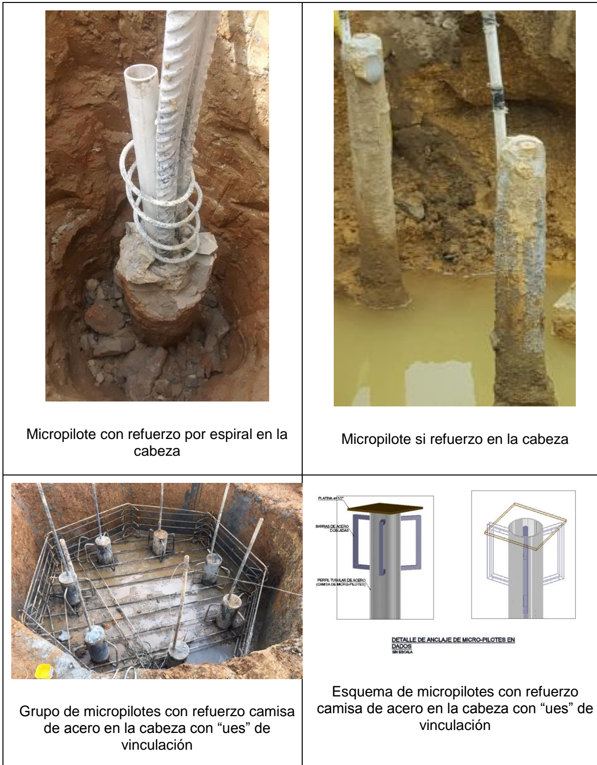
Figura 9. Diferentes refuerzos en cabeza de micropilotes
