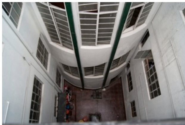
Imagen 26. Patio sobre las circulaciones. Fotografía: G.Fuentes
