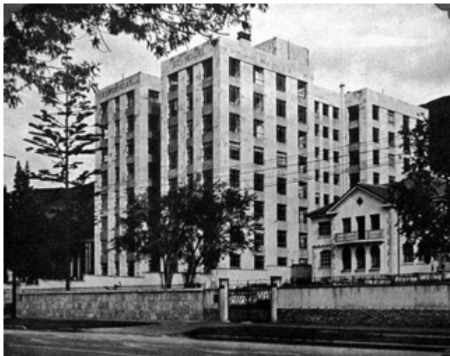
Imagen 5. Edificio para albergar las comisiones de la Conferencia Panamericana. Residencias el Nogal Calle 77 con Carrera 7.
