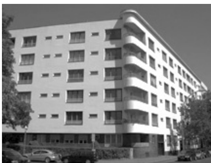
Imagen 22. Casa de Apartamentos Hohenzollerndamm 35–36
