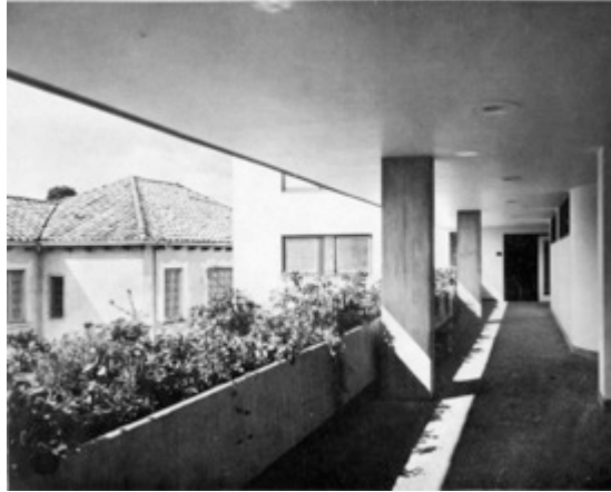
Imagen 51. Desde el corredor de acceso a los apartamentos dúplex. Fuente: La vivienda de G.B. Carlos Niño – Fernando Montenegro.
