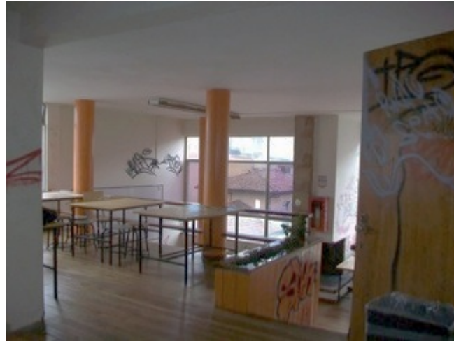
Imagen 40. Vista del acceso del apartamento en la esquina norte de tres niveles.
