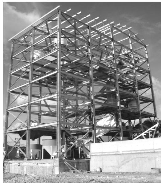
**Figura 5. Estructura aporticada de Acero**
