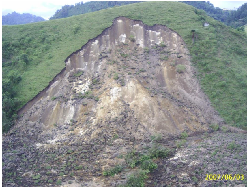
Figura 2. Deslizamiento de suelos de caída piroclástica sobre esquistos arcillolíticos del Complejo Quebradagrande, nótese el depósito coluvial esparcido horizontalmente sobre la pata del talud con forma llana (lleno Hidráulico en construcción), la horizontalidad del depósito coluvial evidencia saturación de la capa de suelos volcánicos que se deslizaros por esta condición.
