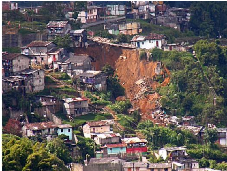
Figura 13 deslizamiento ocurrido en el barrio la Avanzada en noviembre de 2013 los materiales involucrados fueron suelos de la cubierta de cenizas sobre Depósitos de Flujos de Lodo de la Formación Casabianca. Fuente Diario La Patria.
