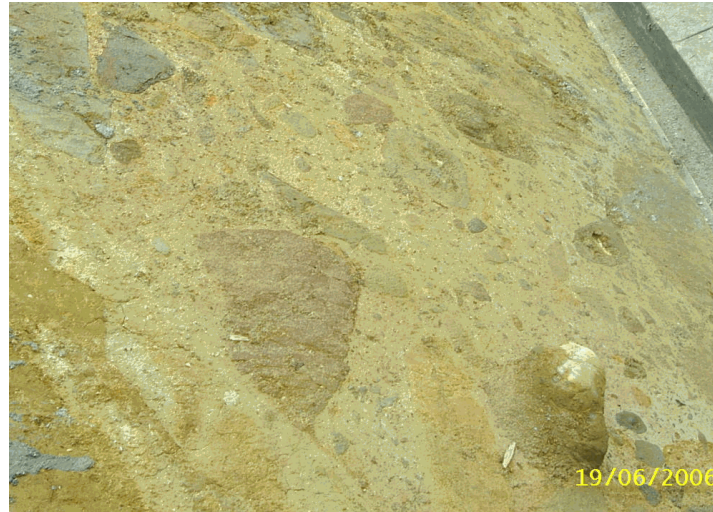
Figura 12. Perfilado de talud sobre Depósitos de Flujos de Lodo de la Formación Casabianca, se observan bloques de roca en estado saprolitizado cortados con pala.
