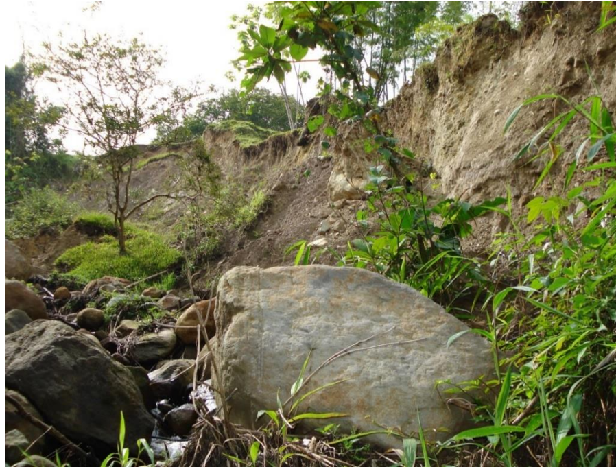
Figura 8. Afloramiento de conglomerados de la Formación Manizales por socavación de fondo de la quebrada el Topacio- La Francia sobre estos materiales que están además en reptación.
