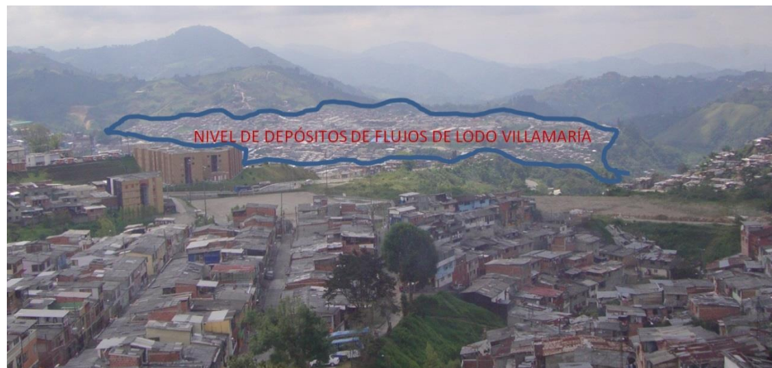
Figura 9 Nivel de depósitos de flujos de lodo de Villamaría muy por debajo de los depósitos de flujos de lodo del flanco sur del casco urbano de Manizales.
