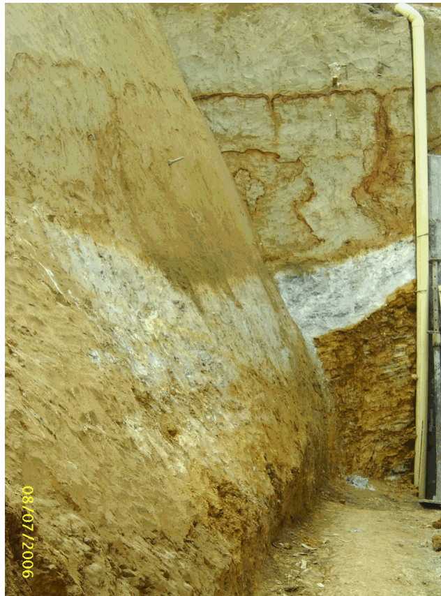
Figura 4. Corte en escuadra del terreno para construcción de vivienda, sector Alta Carola, afloramiento de esquistos arcillolíticos del Complejo Quebradagrande mostrando su suelo residual (franja blanca con espesor inferior a un metro), lo suprayacen depósitos de Caída Piroclástica.
