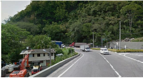
Figura 4-3: Inicio Ruta del Sol
