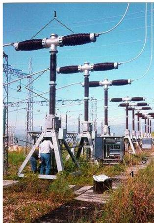
FIGURA 2: Interruptores de potencia tipo FL245.
