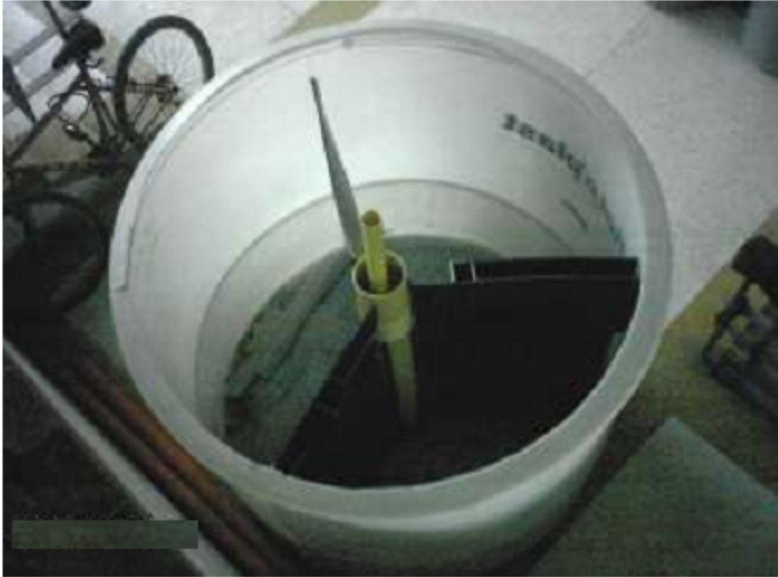
Figura 4.3: Fotografía desde la parte superior de la planta construida
