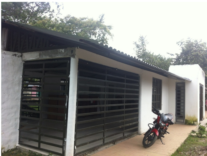
1. Caseta para el encuentro. Esta es la caseta que se construyó en el barrio Villa Juliana de Villavicencio, gracias a la acción de servicio social.
