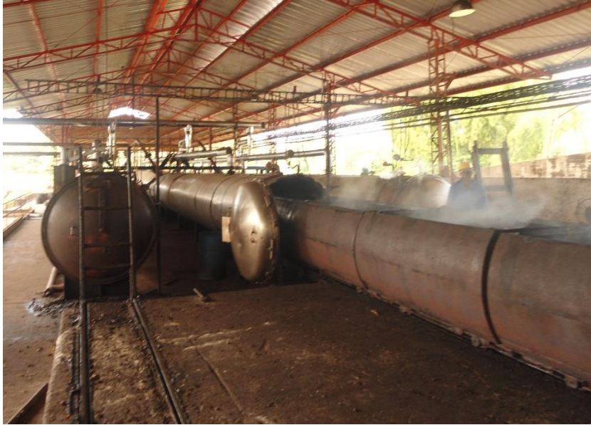
Ilustración 5: Vagonetas saliendo de autoclaves
