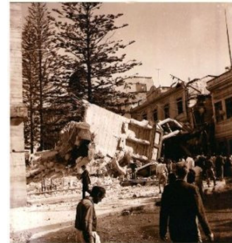
Imágenes de una torre menor de la Catedral de Manizales, colapsada en el sismo de 1962. Centro de Historia de Manizales
