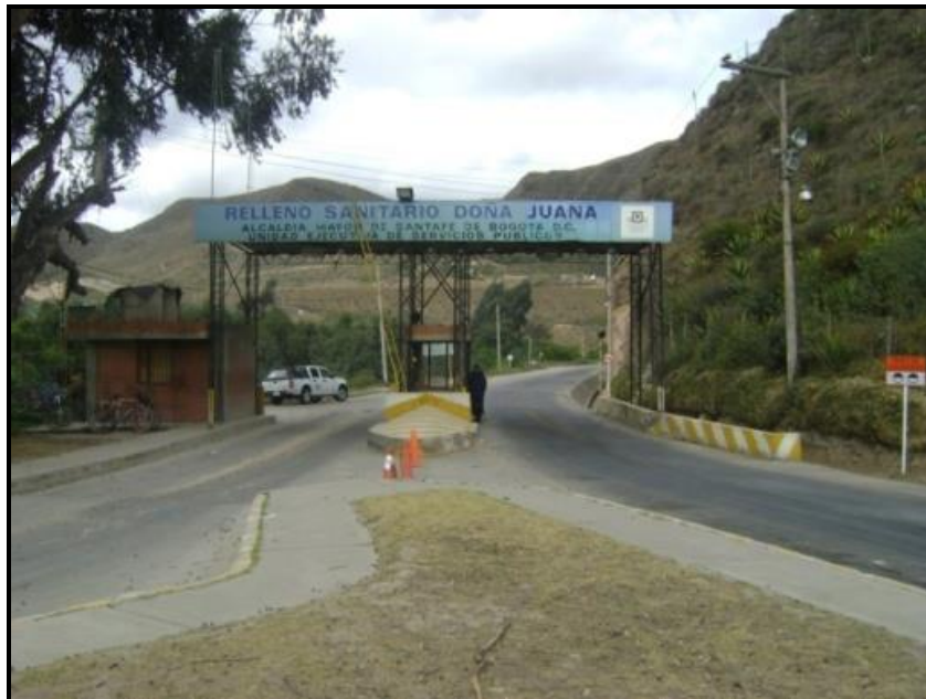
Figura 5-1. Entrada al Relleno Sanitario Doña Juana - RSDJ
