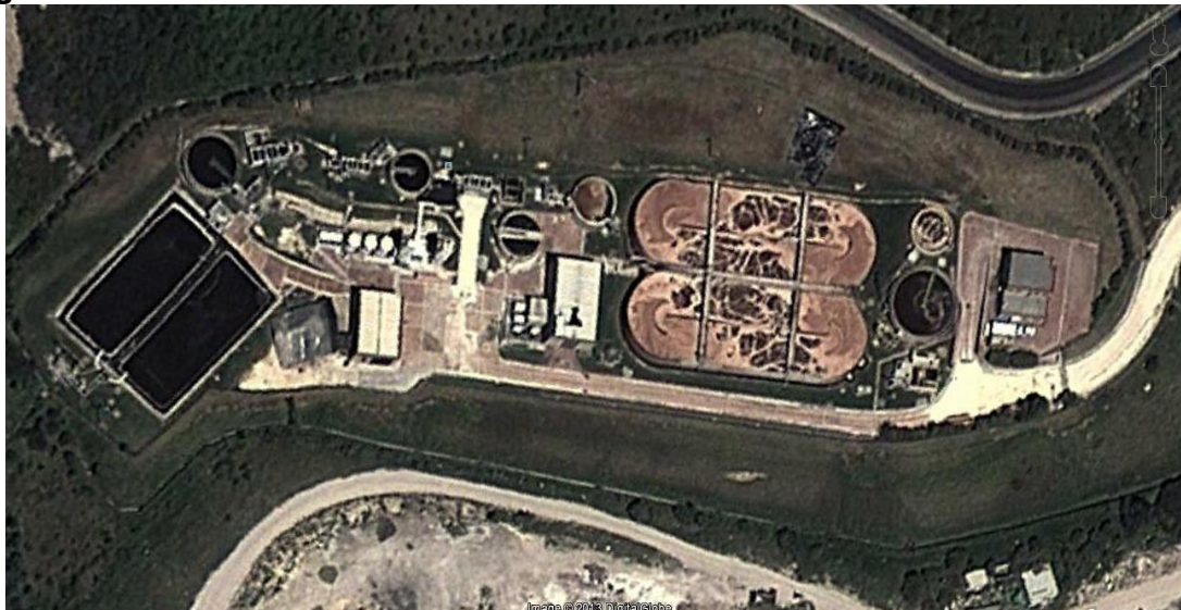
Figura 5-9. Foto de Planta del Sistema de Tratamiento de Lixiviados.
