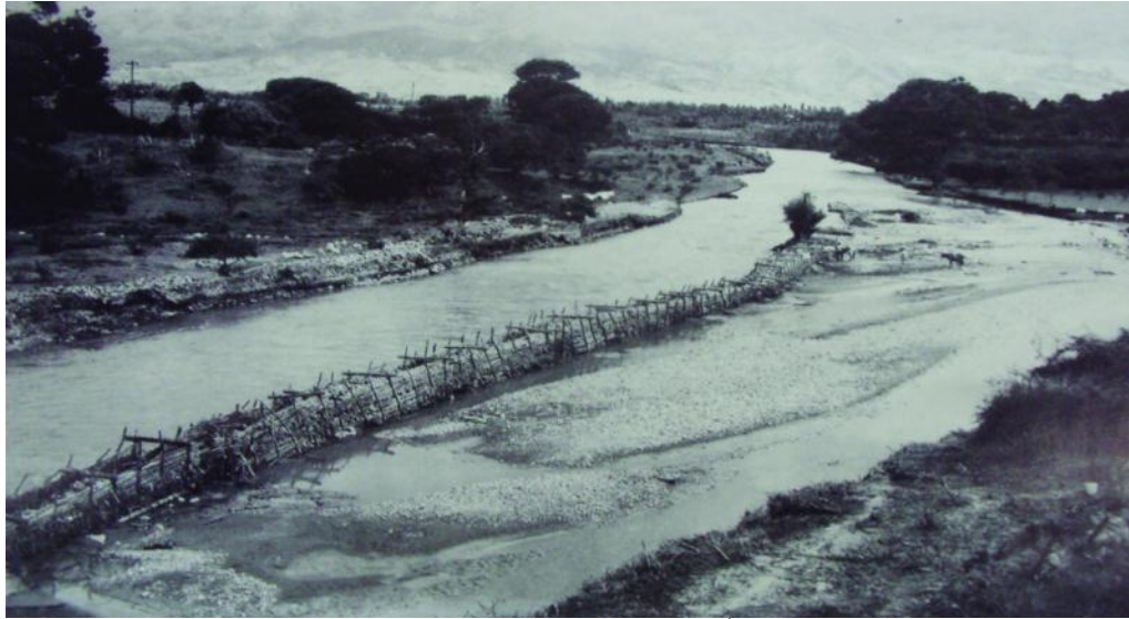
Figura 11. Obras de rectificación del río de Medellín entre 1941 y 1942.
