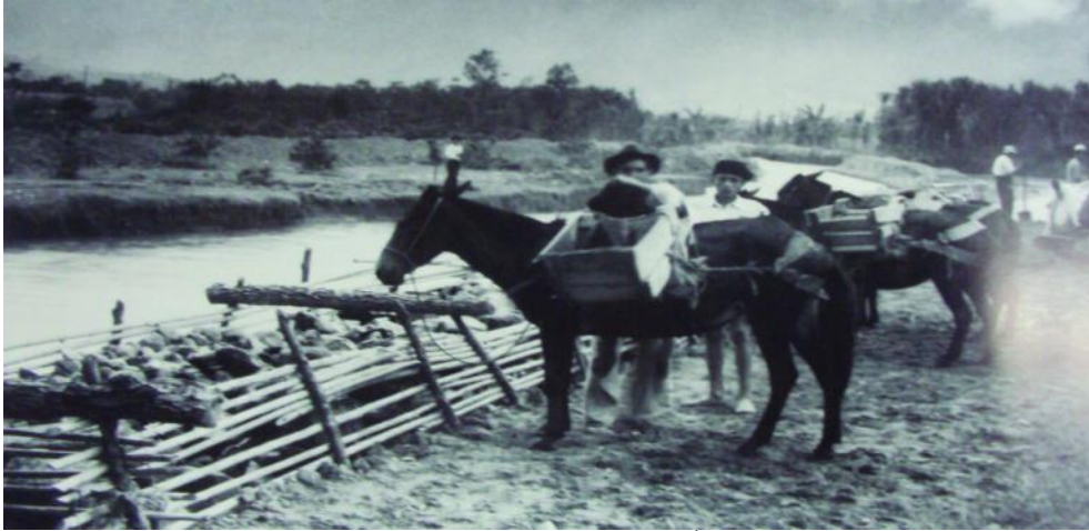
Figura 8. Obras de rectificación, río Medellín, 1941-1942.
