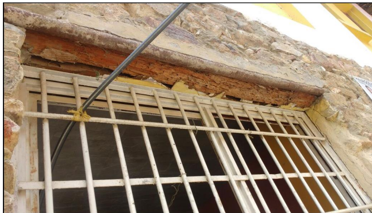
Fig. 13 Detalle de ventana con dintel en madera. Elaboración propia.
