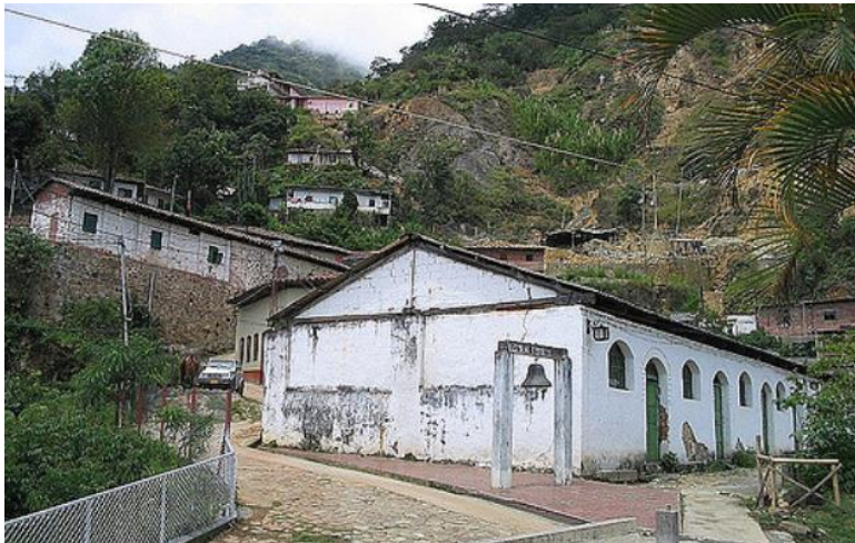
Imagen 2. Construcciones en bahareque, presencia de muros de contención y caminos empedrados.
