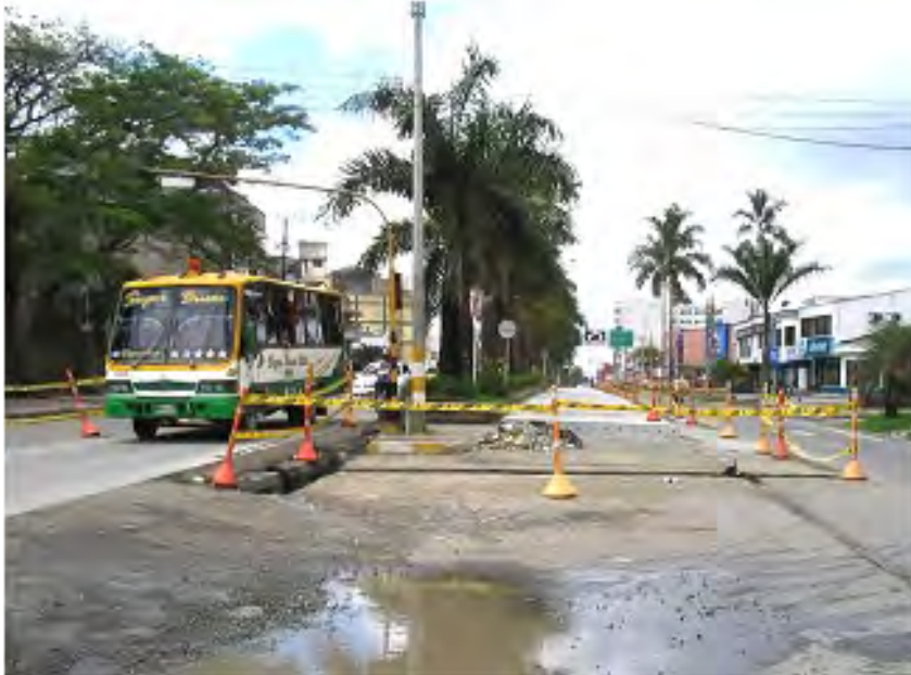
Figura 12. Obras en la avenida 30 de agosto.
