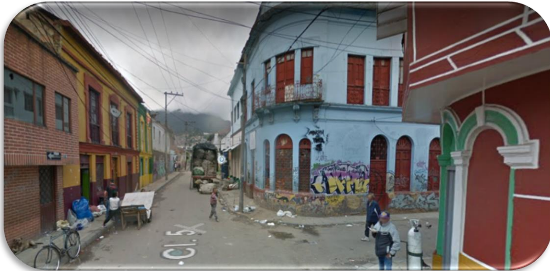
Foto 5-6. Barrio San Bernardo, sector de mayor deterioro. Calle 5 con 11a.
