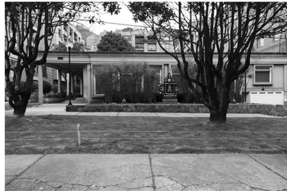
(2) 3.36b fotografía fachada frontal
