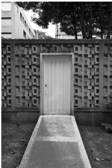
3.42d-e-f Fotografías detalles texturas en cemento, con las que se determinan los espacios desde el exterior, en este caso calado cemento jardín posterior y textura zona de noche Fuente: Autor
