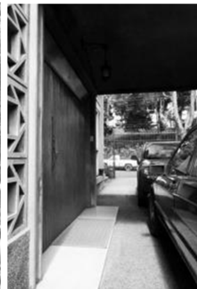
(4)2.38d fotografía acceso peatonal y vehicular
