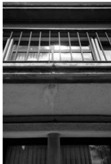
3.35f fotografía detalle encuentro entre columna, placa y baranda
