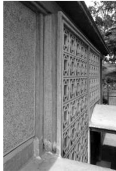
3.35c fotografía detalle tratamiento de muro en calado de cemento
