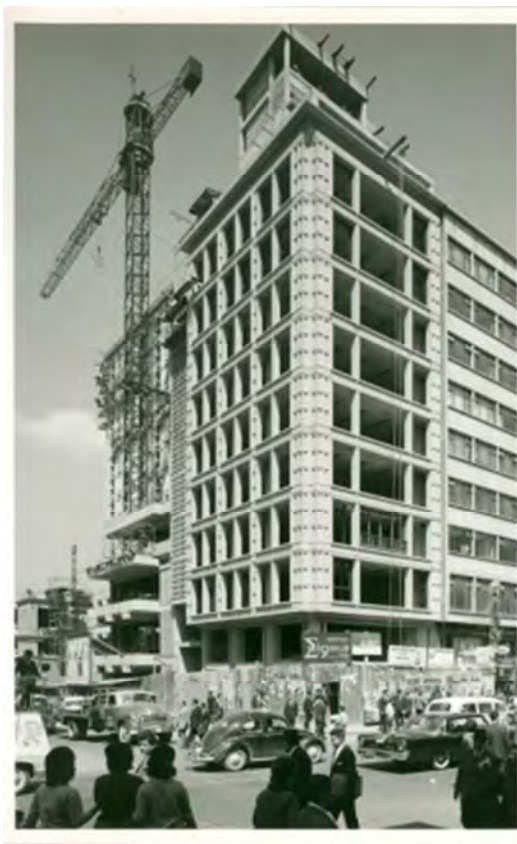
1.4b. Construcción edificio Quintana Fuente: Paul Beer
