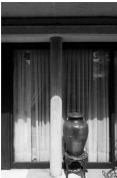
3.35e fotografía detalle encuentro columna y placa
