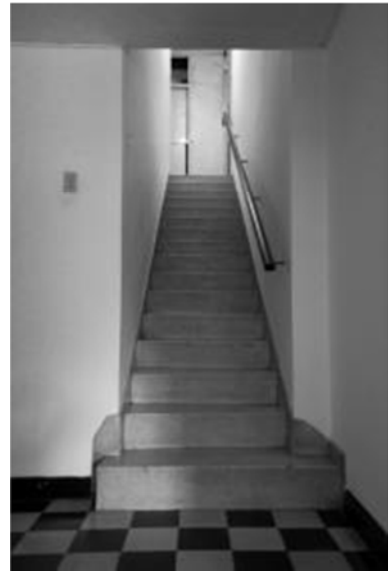
(28)3.33c fotografía escalera de servicio desde el nivel inferior
