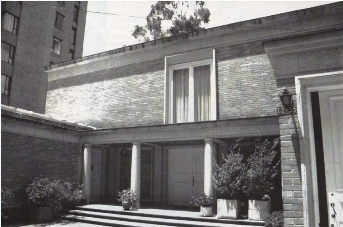
(1)3.27a Fotografía fachada frontal y acceso principal Fuente: Arquitecturas y Lirismo matérico
