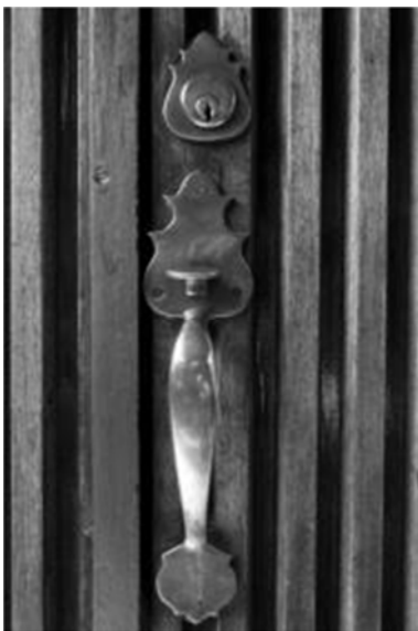
3.35d Fotografía detalle herraje puerta principal Fuente: Autor
