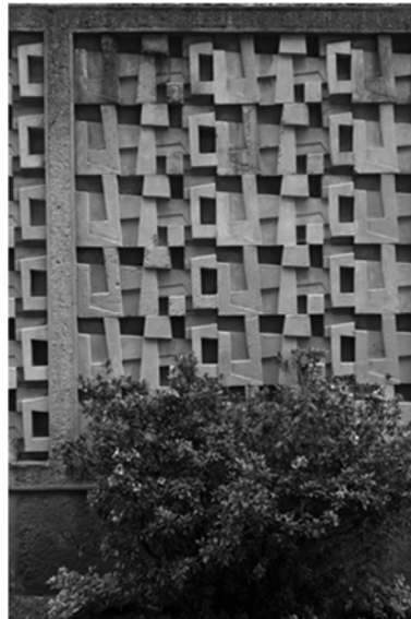
3.42d-e-f Fotografías detalles texturas en cemento, con las que se determinan los espacios desde el exterior, en este caso calado cemento jardín posterior y textura zona de noche Fuente: Autor
