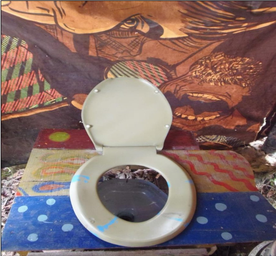
Fotografía 2. Baño seco. Fuente: Blanco, 2016
