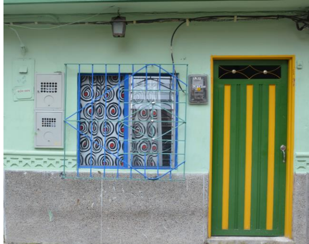
Figura 44. Zócalo de pañete. Sector Las Araucarias
