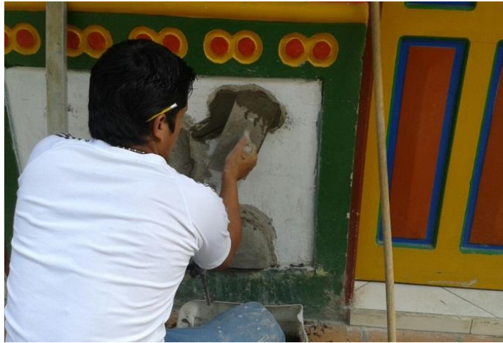
Figura 52. Aplicación de mezcla
