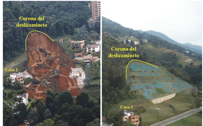
Figura 2. Situación global antes y después de ejecutar las obras de estabilización. Fuente: Adaptado de [23, 24]
