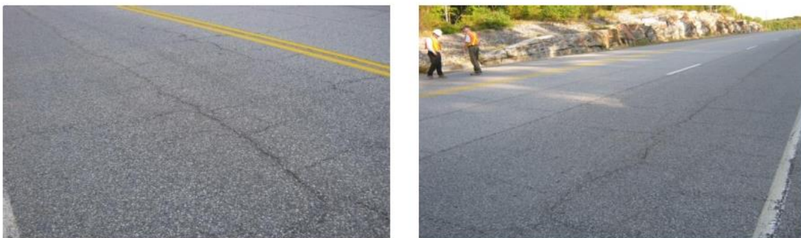
Figura 4. Estado del tramo de prueba de la autopista Trans-Canadá en el cual se usaron asfaltos modificados con aceites
