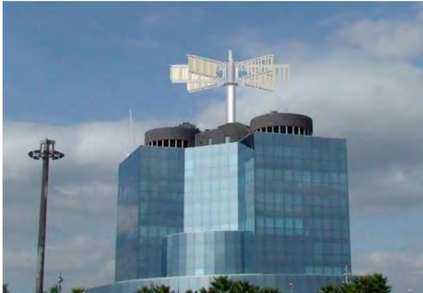
Figura 5-25: Aerogeneradores de eje vertical en cubierta de edificio [82].
