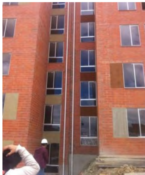
Figura 5-31: Sistema constructivo de muros de carga en mampostería reforzada [la autora].
