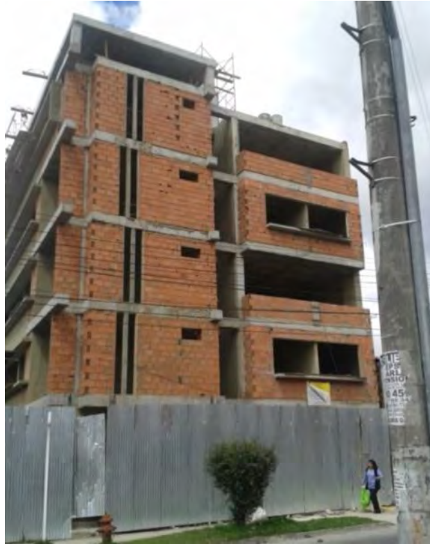
Figura 5-33: Edificio con sistema estructural de pórticos y fachadas en bloque de arcilla en Bogotá [la autora].
