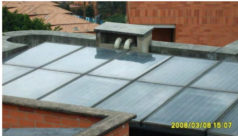
Figura 5-20: Paneles solares para AC en edificio de viviendas tipo 5 en Medellín [la autora].
