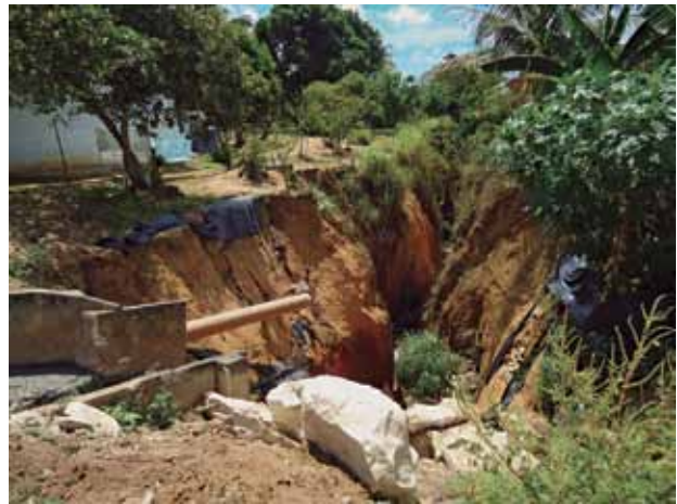
Figura 7. Voçoroca na área urbana de Alhandra - PB. Fotografia de Gilvone Freitas 2011.
