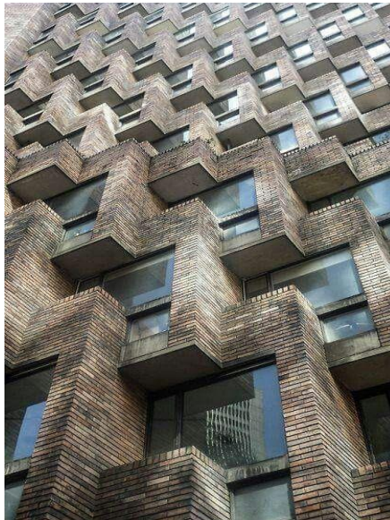
Ilustración 1 Fachada Edificio FONCEP
