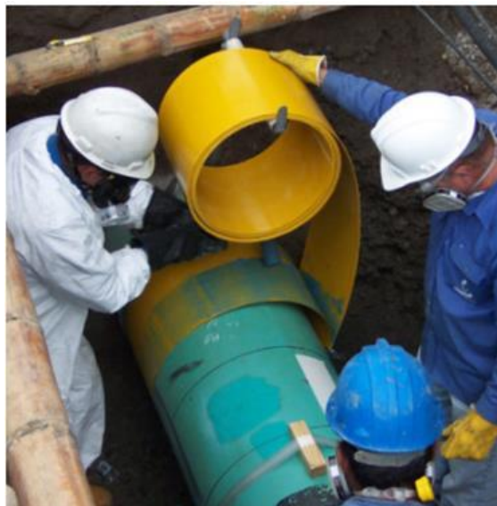
Fotografía N°: 14. Instalación de la cinta Clock Spring.
