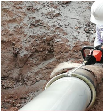
FOTO 11: Prueba de discontinuidad
