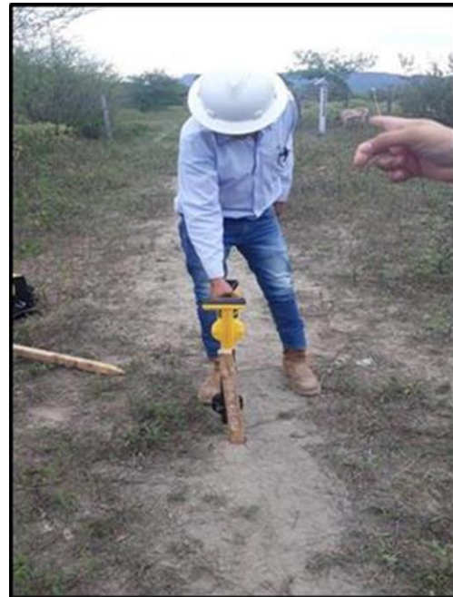
Fotografía N°: 18. Detección de tubería en campo.
