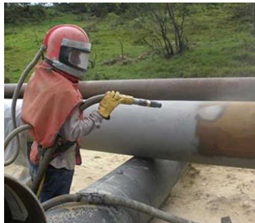
Fotografía N°: 25. Limpieza tubería mediante sand blasting.
