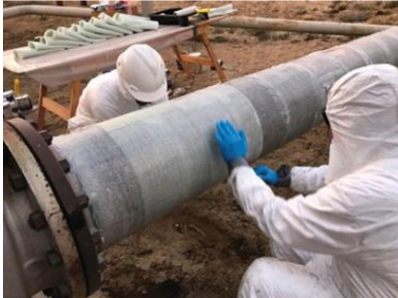
Fotografía N°: 3. Instalación de cinta Wax Tape o cinta de cera sobre tubería de gasoductos.
