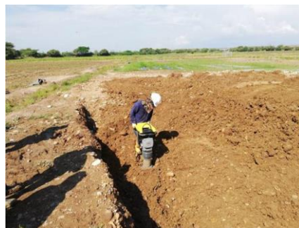
Fotografía N°: 62. Compactación con equipo Manual.
