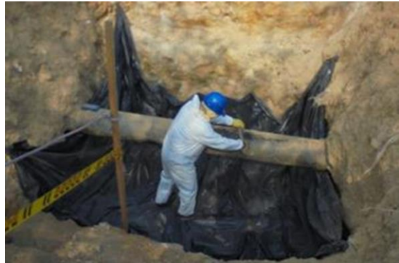
Fotografía N°: 24. Limpieza de rasqueteo de la superficie de la tubería.
