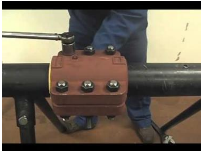
Fotografía N°: 2. Instalación de grapa apernada sobre tuberías de gasoductos.
