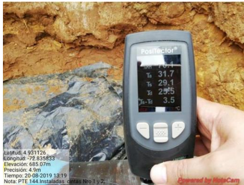
Fotografía N°: 57. Medición de parámetros ambientales antes de pintar.
