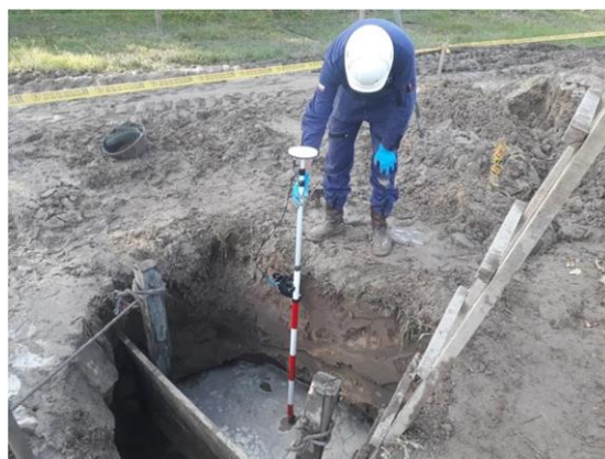
Fotografía N°: 46. Localización tubería en área a excavar.
