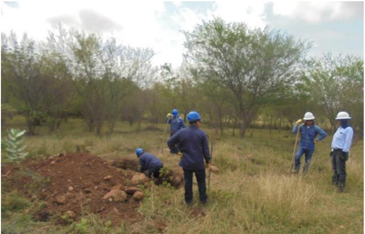
Fotografía N°: 19. Excavación manual apiques para la identificación de tubería.
