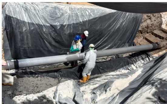
FOTO 5: Aplicación de pintura
