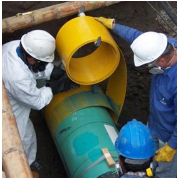
Fotografía N°: 4. Instalación de cinta en fibra Clock Spring sobre gasoductos.
