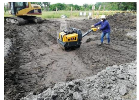
Fotografía N°: 61. Compactación con equipo Mecánico.
