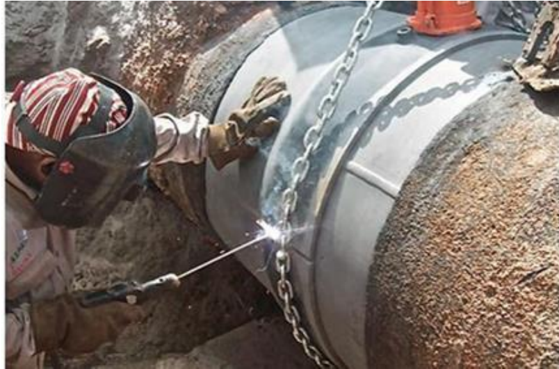
Fotografía N°: 1. Instalación de camisa soldada tipo B sobre tuberías de acero.
