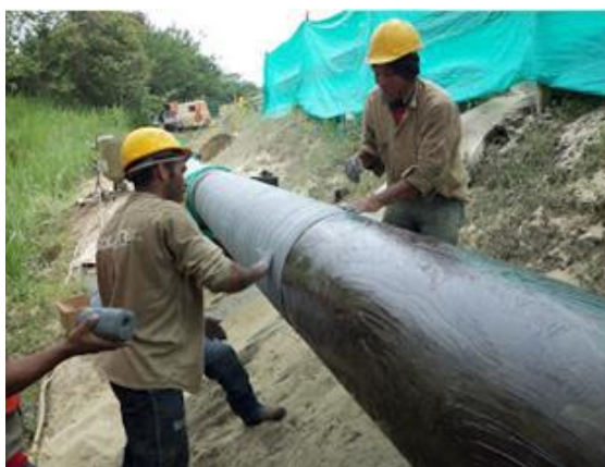
Fotografía N°: 11. Instalación de la cinta Wax Tape.
