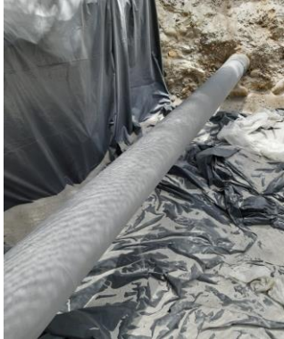
FOTO 1: Preparación superficial arenado metal casi blanco SSPC sp 10
