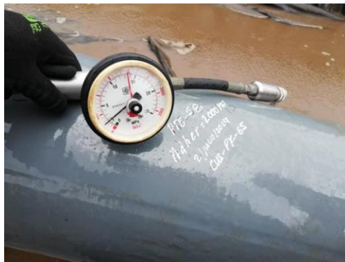
Fotografía N°: 59. Medición de adherencia de la pintura aplicada.
