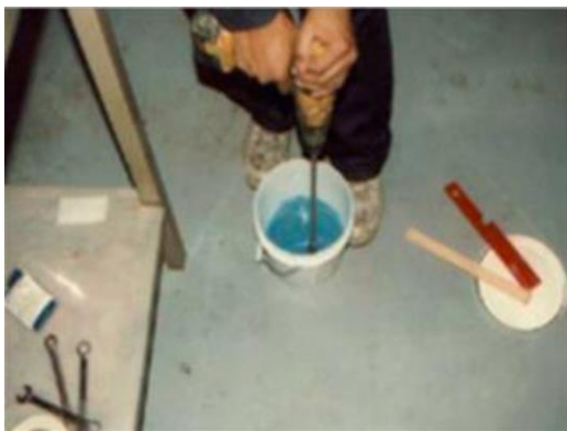
Fotografía N°: 31. Mezclado del producto catalizador.
