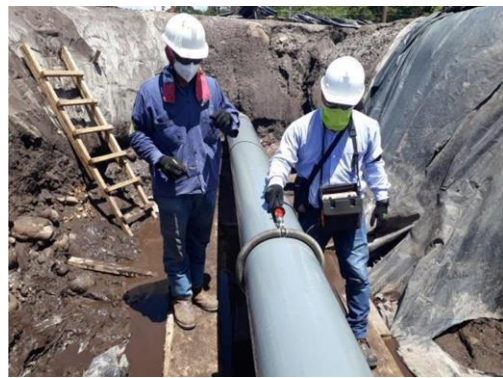
Fotografía N°: 58. Medición de continuidad holiday de la pintura
