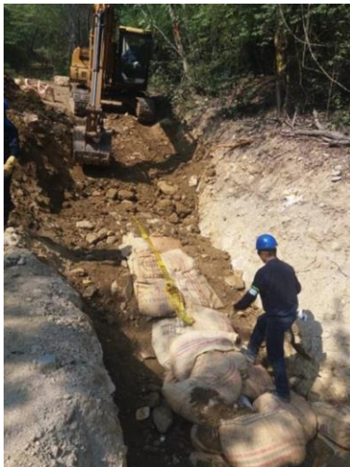
Fotografía N°: 63. Relleno mecánico de la excavación.
