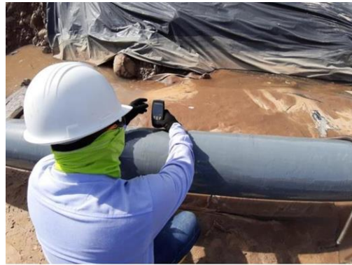
Fotografía N°: 56. Medición de espesores del nuevo recubrimiento.
