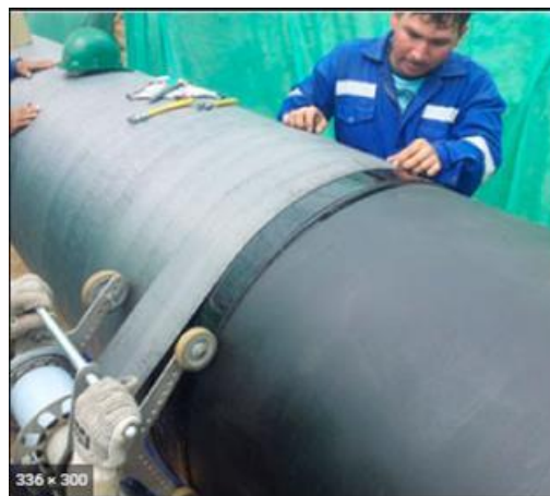
Fotografía N°: 13 Instalación de cintas Polyguard.
