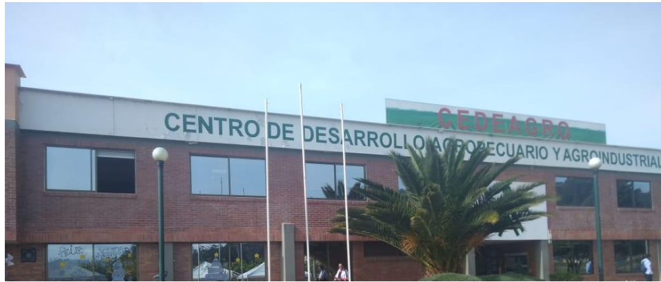
Figura VII. Instalaciones SENA - Centro de formación Duitama. Fuente (Propiedad del autor)
