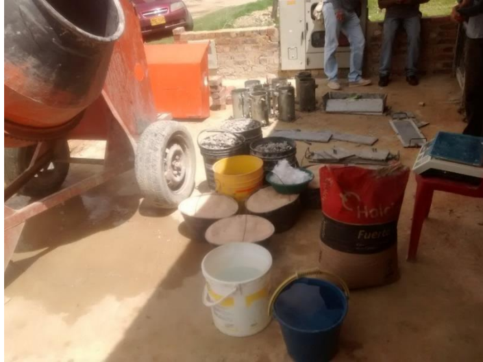
Figura 3. Materiales utilizados para la fabricación de las muestras de concreto
