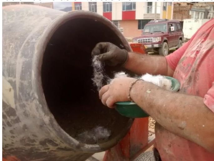
Figura 4. Incorporación de fibras sintéticas a la mezcla de concreto
