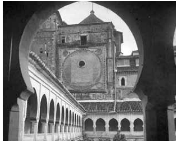
Figura 2. Entre 1920 y 1940 el fotógrafo Adolfo Almató realizó esta imagen, en la que se aprecia que el rosetón del brazo septentrional del crucero del templo de Santa María de Guadalupe aún estaba cegado. Fundación Instituto Amatller de Arte Hispánico, Archivo Mas.
