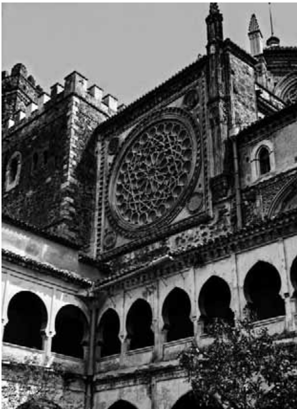
Figura 3. Imagen captada en 1963, en la que apreciamos que las obras de restauración realizadas por don Luis Menéndez-Pidal Álvarez han descubierto el rosetón de la iglesia del Monasterio de Guadalupe. Fundación Instituto Amattler de Arte Hispánico, Archivo Mas.
