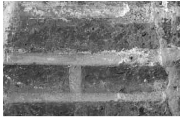
Figura 18. Los alarifes mudéjares lograron la protección del ladrillo y la regularidad estética de sus fábricas mediante el enlucido y pintado de almagre, ayudándose de agramilados, como observamos en este detalle de la portada anterior. Fotografía de Pilar Mogollón.
