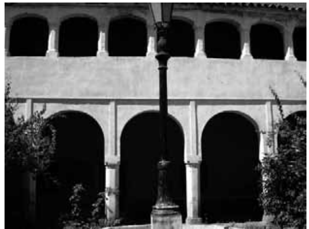
Figura 16. Patio de la antigua Casa Prioral, luego Tribunal de la Inquisición de Llerena, Badajoz, único ejemplo localizado en Extremadura en que se utilizó un mortero mixto de cal aérea y yeso. Fotografía tomada antes de la última restauración. Fotografía de Pilar Mogollón.
