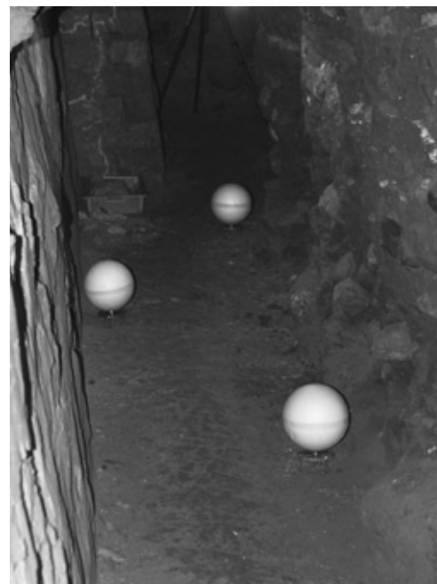
Fotografía 10. Ejemplos de marcadores (targets) puestos en uno de los túneles del PIAT.
