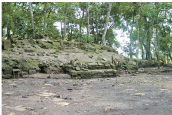
Fotografía 1-I : Estado de abandono de 9L-101 (1970-2003)
