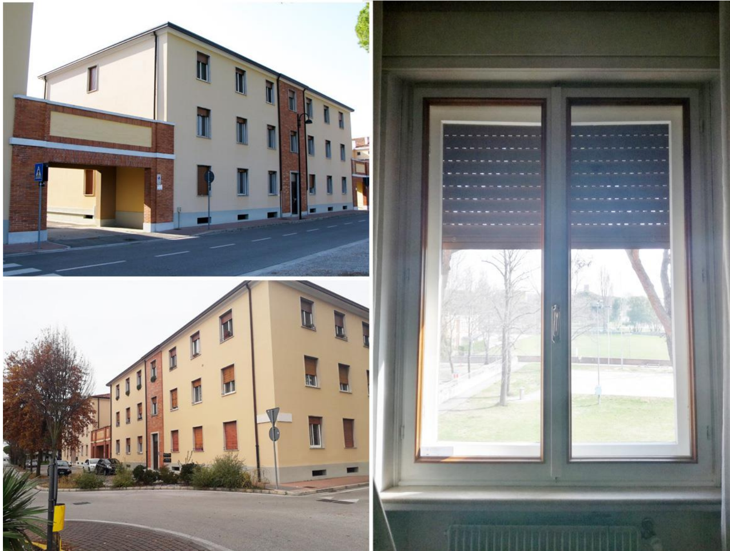
Figura 23_Case dei tecnici del caprolattame, prospetto est in via Guglielmo Marconi (alto sinistra); prospetto sud in viale Marconi (basso sinistra); particolare infisso originale, vista dall'interno (destra)..
