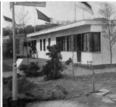
2. La casa dell'arch. Hilberseimer.
