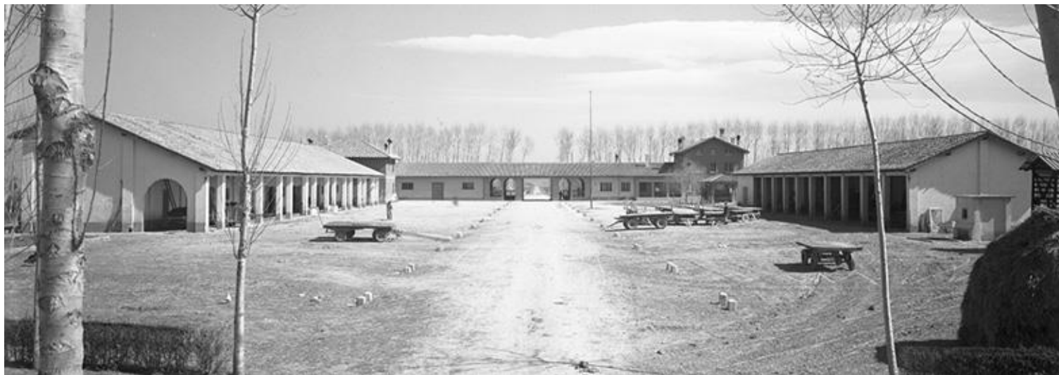
Figura 26_Agenzia 2. Complesso "Vitelleria".
