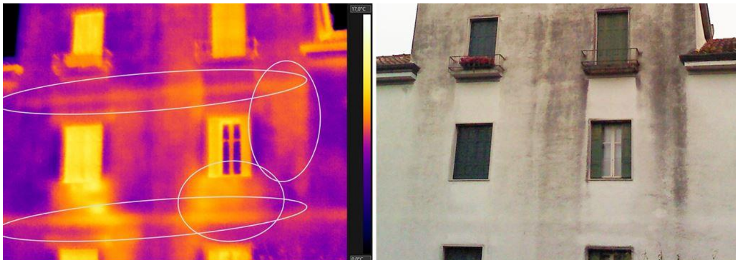
Figura 4_Case dei funzionari. Immagine termografica (sinistra); parte dell'edificio analizzato corrispondente.
