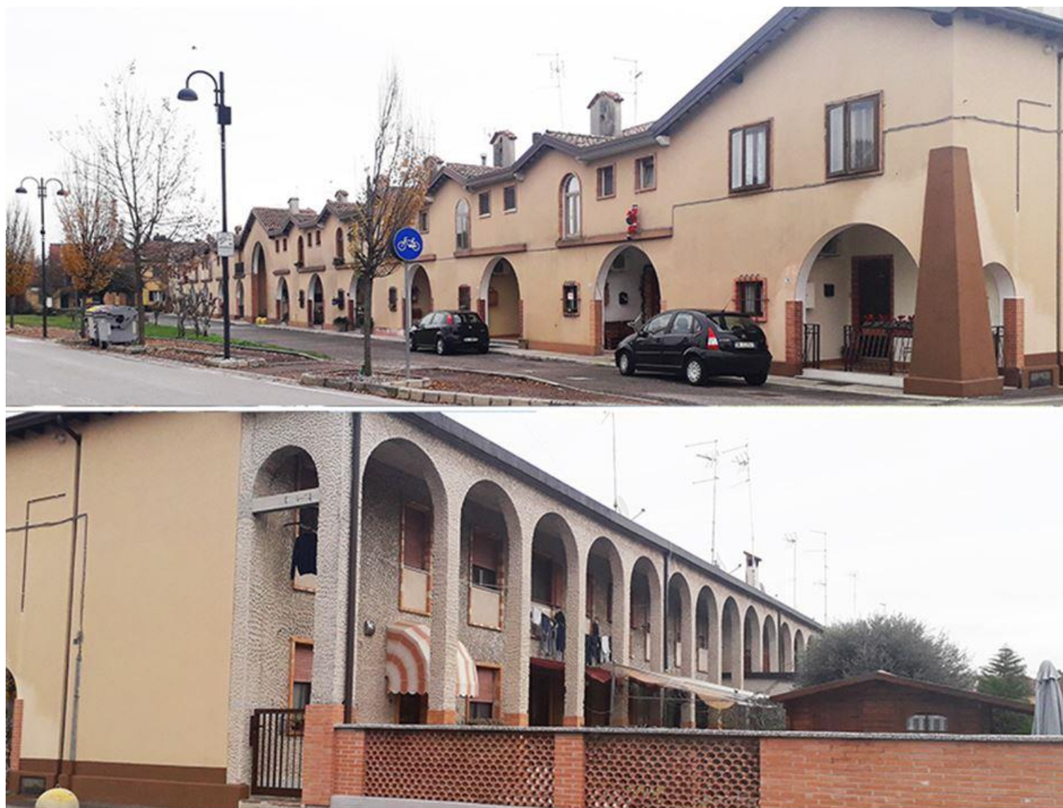
Figura 14_Case operaie tipo 01M. Prospetto nord; prospetto sud blocco 0324.
