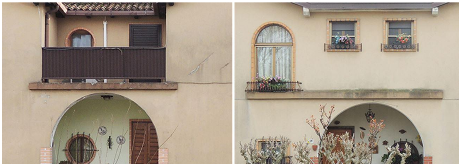
Figura 19_Case operaie tipo 01M. Confronto tra l'unità centrale frontale rivolta a nord con terrazzino (blocco 0318) e quella tamponata (blocco 0324).
