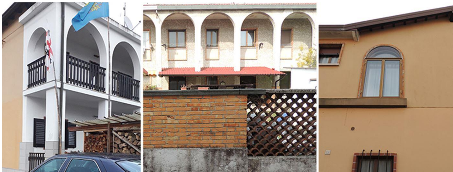
Figura 18_Case operaie tipo 01M. Modifiche ai fronti: realizzazione balconate sul fronte sud (sinistra); aggiunta tettoie (centro); inserimento doppia finestra (destra).
