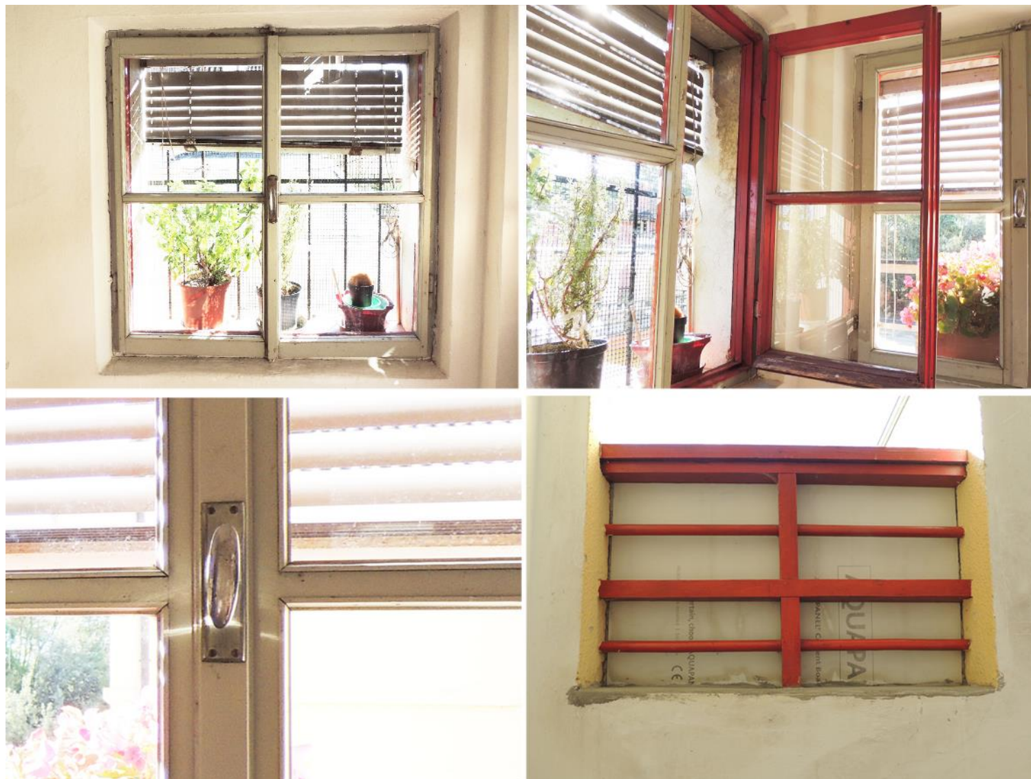
Figura 14_ Case Ville di Sopra B. Particolare doppia coloritura dell'infisso (in alto); particolare maniglia (basso sinistra); particolare parapetto (basso destra). 2019.
