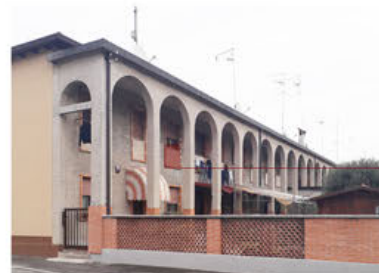
2018 blocco 0324 | lato sud G.S.L.
