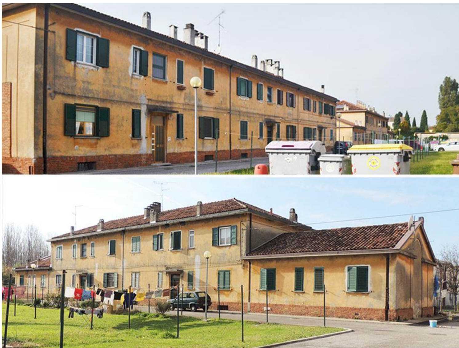
Figura 7_Case operaie tipo 4-4bis. Prospetto ovest blocco 0308 (in alto); prospetto ovest blocco 0311 (in basso).
