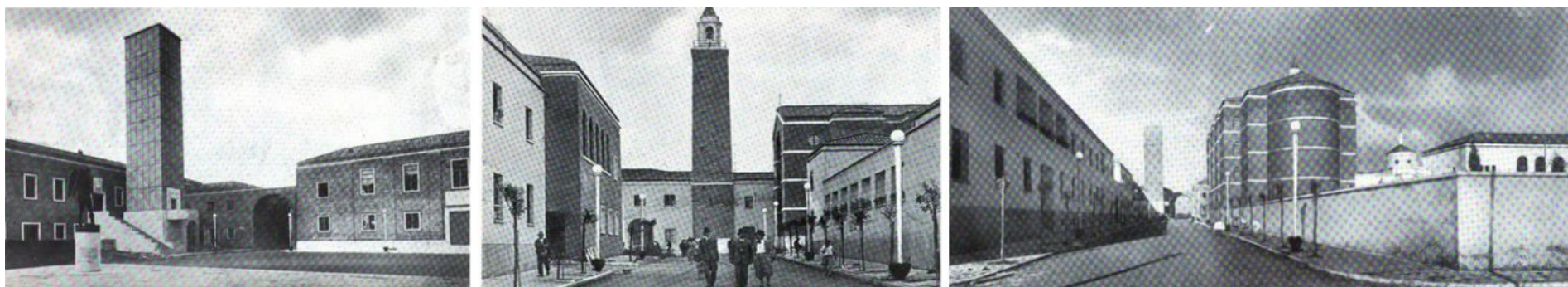
Figura 12. Aprilia. Palazzo Comunale con la Torre Civica e la Casa del fascio (sinistra); vista della Torre Campanaria e dei fianchi della Chiesa (centro); vista della Torre Civica e della Chiesa (destra).
