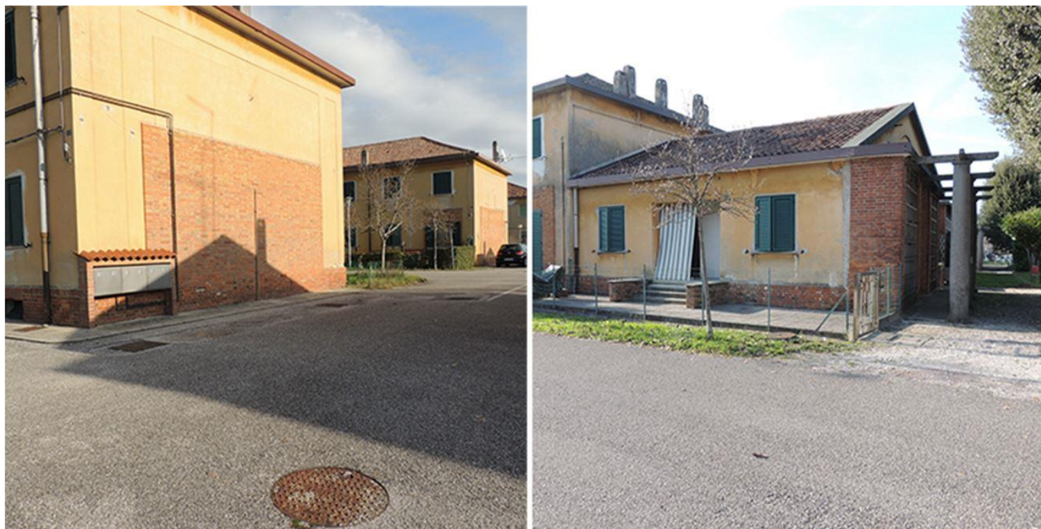
Figura 12_ Case operaie tipo 4-4bis. Rivestimento con mattoni faccia a vista: prospetto sud blocco 0308 (sinistra); prospetto nord blocco 0309 (destra).
