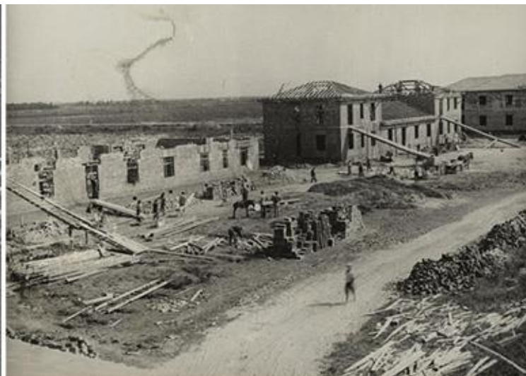
Figura 24_Agenzia 1. Blocco residenziale in fase di costruzione.
