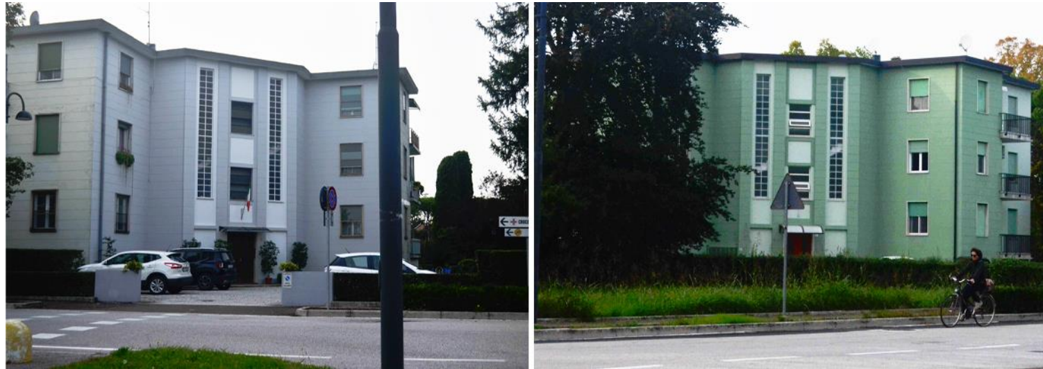
Figura 19_Case di tecnici, blocco sud, prospetto nord-est (sinistra); blocco nord prospetto sud-est (destra). 2020.
