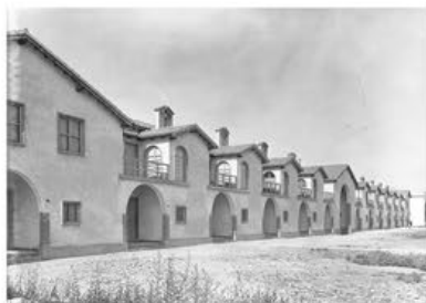
1948 blocco 0324, 0318 | lato nord archivio CID, FFSCN_TV-0611
