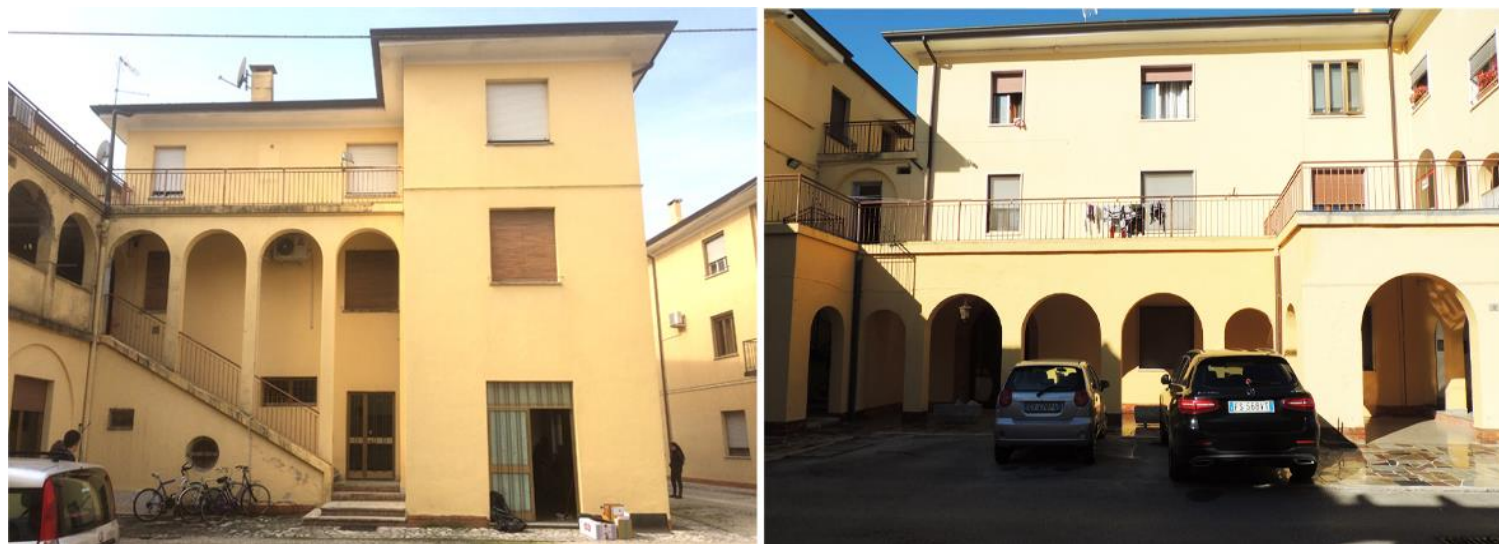
Figura 13_Case Ville di Sopra B, scala interna (sinistra); ballatoi interni (destra). 2019.
