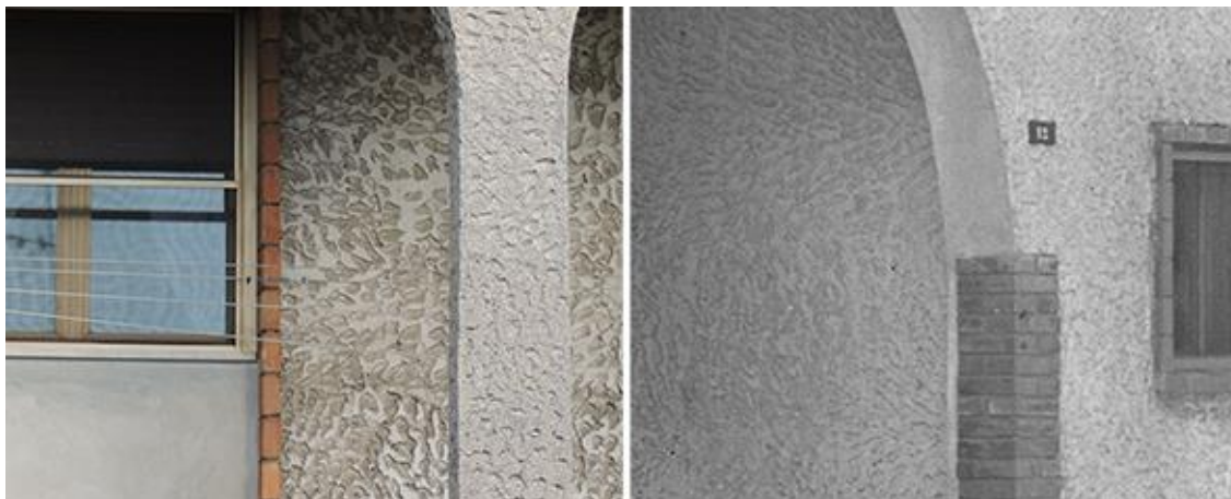
Figura 21_Case operaie tipo 01M. Tecnica di applicazione di intonaco adottato sia per il prospetto sud (sinistra), sia per quello nord (destra).
