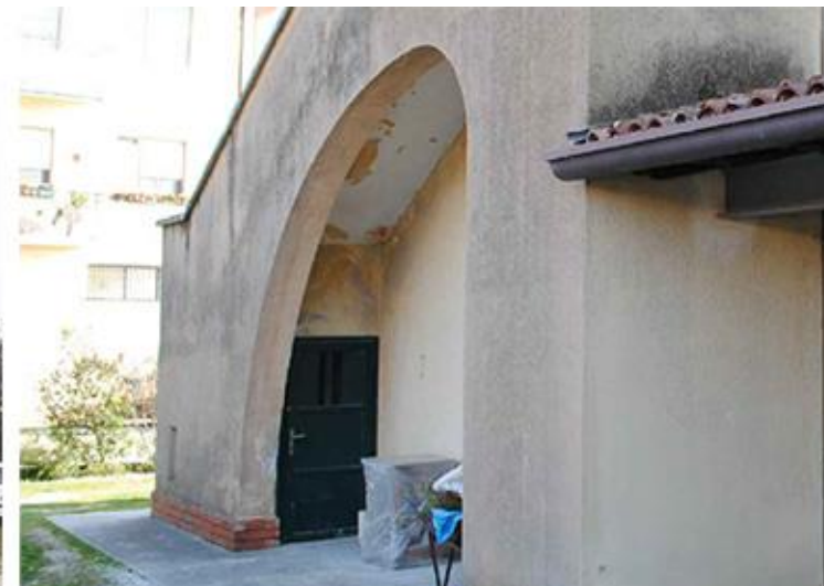
Figura 22_Case di Malisana. Particolare scala a "collo d'oca".
