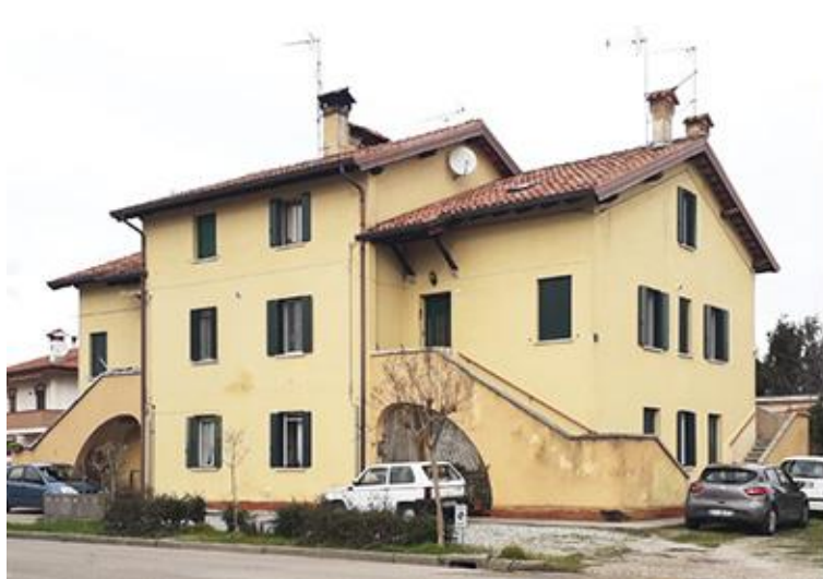
Figura 21_Case di Malisana. Abitazione per i braccianti agricoli prospetto sud-ovest.
