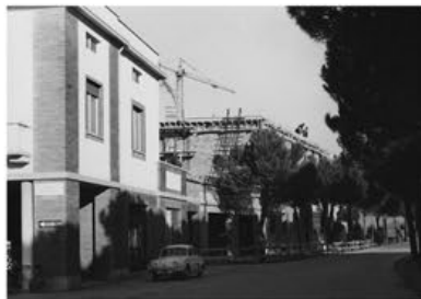
19-- blocco nord | lato est archivio CID, FFSC_A22-075
