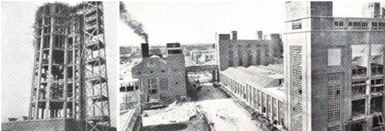
Figura 5. Cantiere della Torre Littoria all'interno della fabbrica (sinistra); Vista stabilimento industriale dopo la fine dei lavori di costruzione (sinistra).
