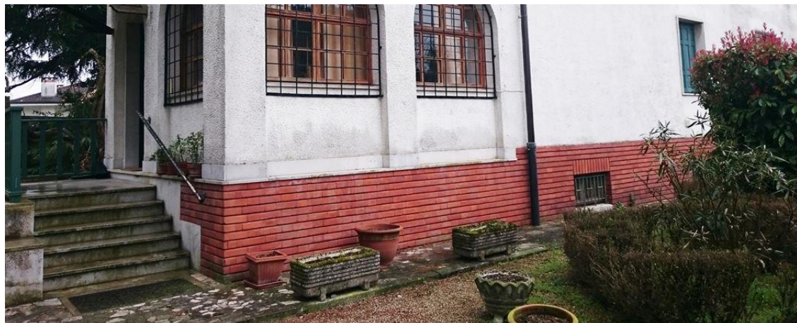
Figura 27_Casa dei funzionari, blocco 0105 particolare zoccolatura in mattoni faccia a vista.
