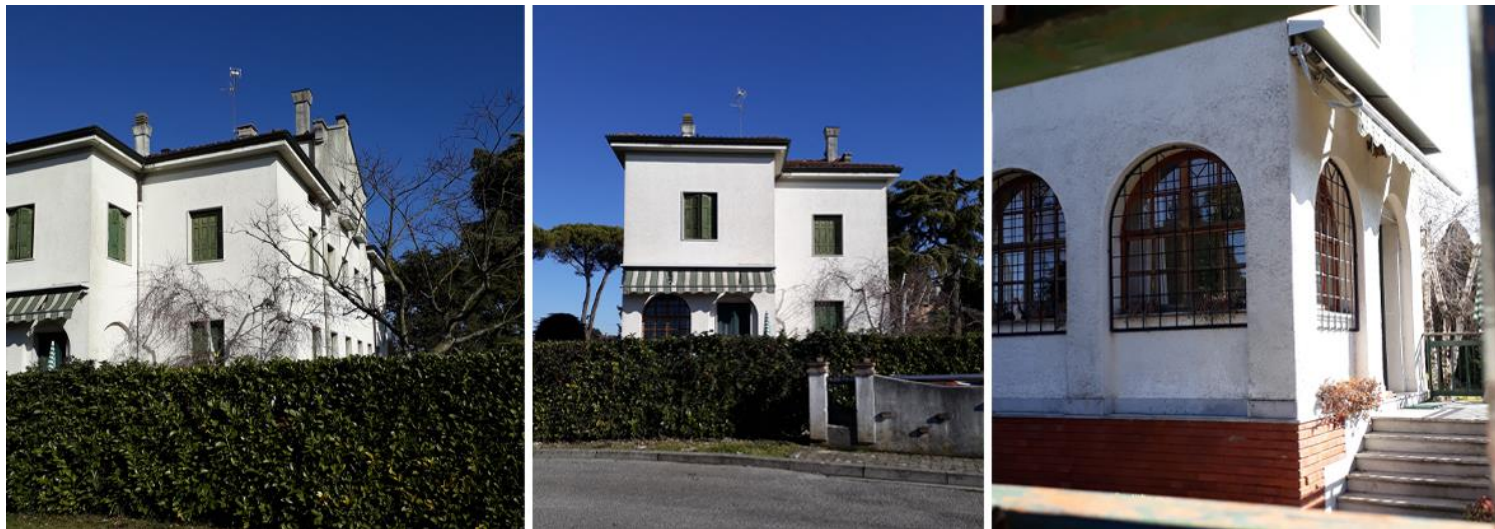
Figura 18_Case dei funzionari, prospetto sud-ovest (sinistra e centro); portico tamponato con ingresso esterno (destra). 2019.
