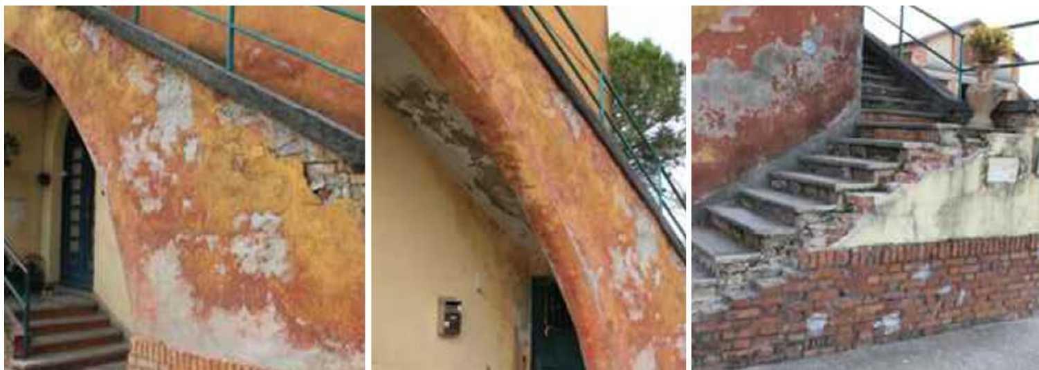
Figura 25_Particolare della scala esterna a "collo d'oca".
