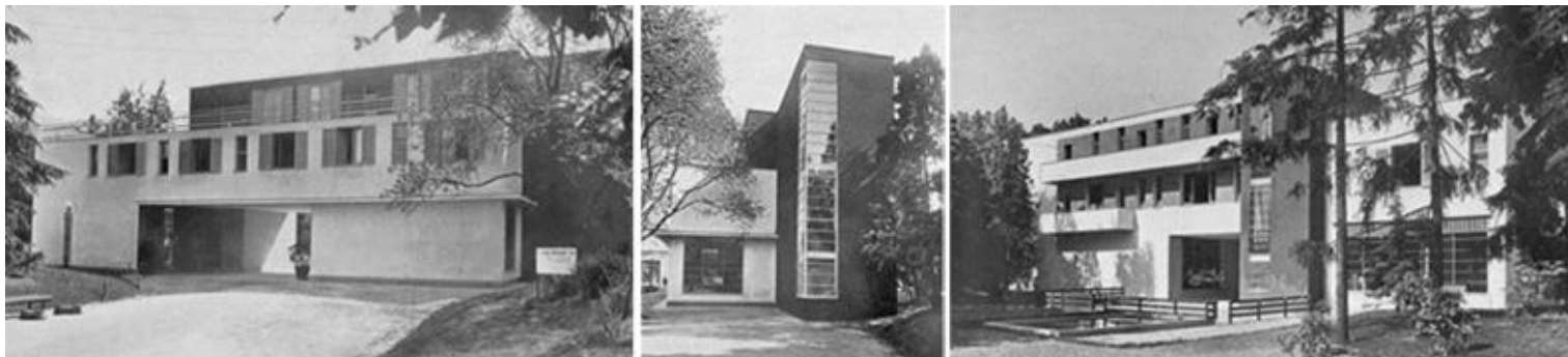
1. Gruppo di elementi di case popolari: androne d'accesso. 2. Vista scala nord. 3. Case di abitazione a ballatoio a sinistra, con vano scala a destra.
