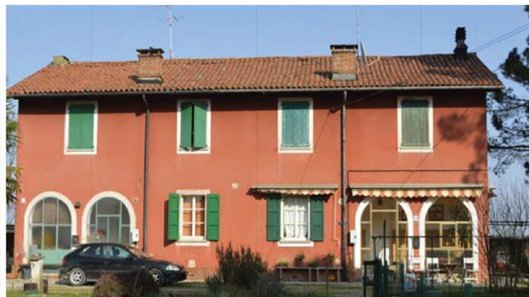
Figura 34_Case dei mungitori, prospetto est.
