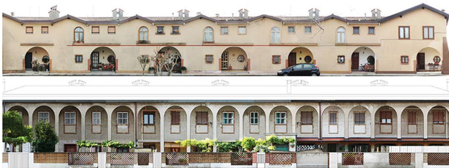
Figura 15_ Case operaie tipo 01M. Foto-prospetto nord blocco 0324 (in alto); foto-prospetto sud blocco 0323 (in basso).
