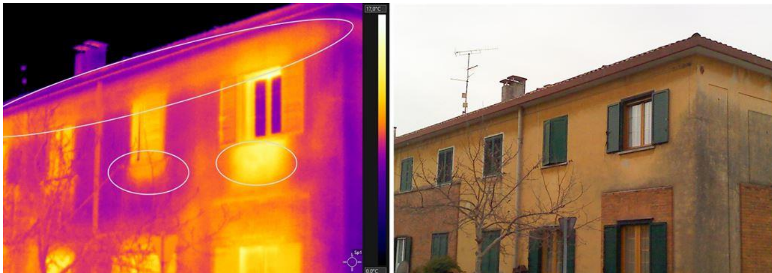
Figura 2_Case operaie tipo 4. Immagine termografica (sinistra); parte dell'edificio analizzato corrispondente (destra).
