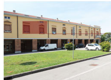
2018 blocco sud | lato nord G.S.L.
