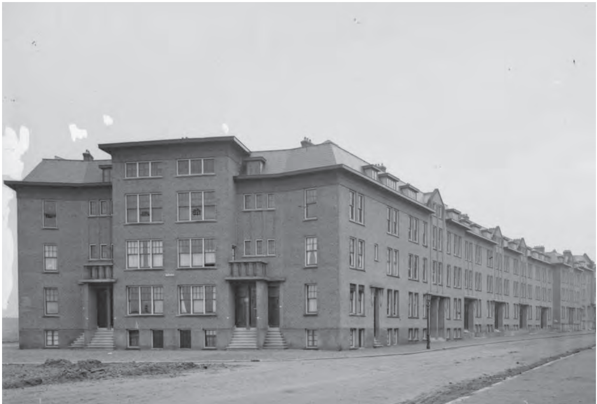
Beukelsweg, Nieuwe Westen, Rotterdam Bron: Stadsarchief Rotterdam, foto: Fototechnische Dienst, F.H. van Dijk
