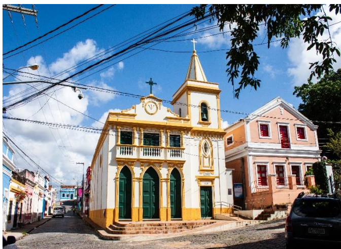
Figura 16 - Fachada da Igreja do Bomfim
