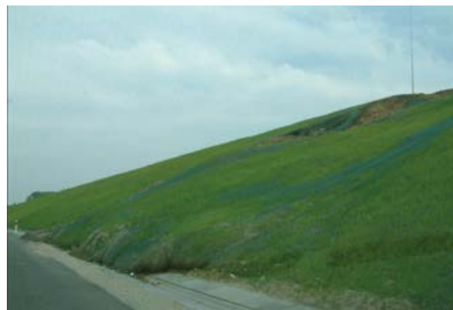
Slika 2. Klizište na prirodnoj padini s nagibom od oko 25°, osigurano geotekstilom/geopletivom za kontrolu erozije bez čavljanja
