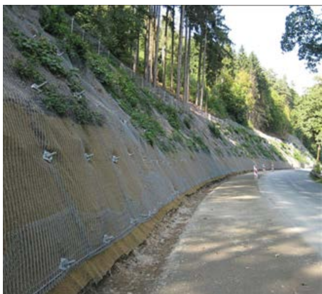
Slika 4. Stabilizacija pokosa žičanom pletenom mrežom od čelika visoke čvrstoće i geopletiva za kontrolu erozije (sustav TECCO® G65/3)
