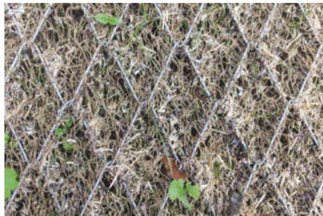
Slika 14. TECCO® GREEN nakon hidrosjetve
