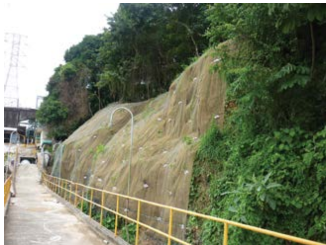
Slika 11. Osigurani stjenoviti pokos u Mirafloresu, u Panami. Geopletivo za zaštitu od erozije može biti dobro rješenje i za pokose nepravilnog oblika.
