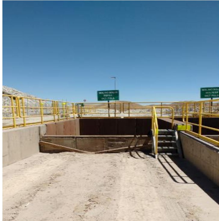
Imagen 10: Hopper por debajo del nivel del piso.
