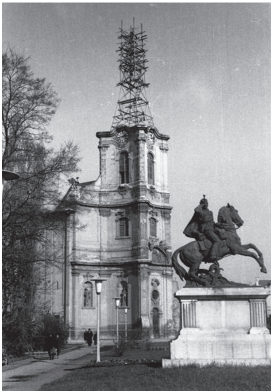
A Nagyboldogasszony tornyának helyreállítása 1969-ben
