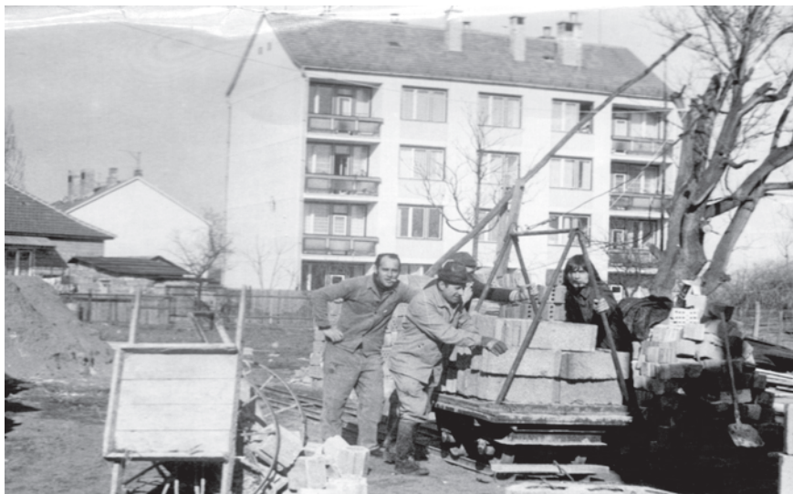
Családi ház építése „kalákában”
