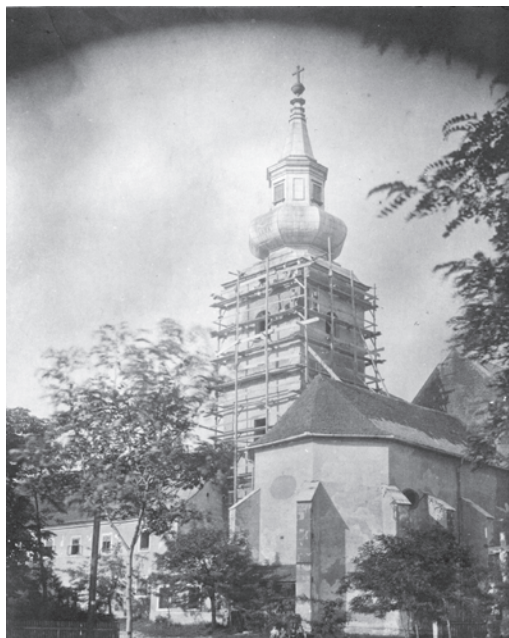
A templomtorony felújítása a 20-as évek végén
