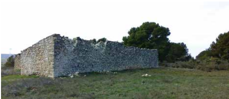
FIG. 17. Corral del Blaio (Fuendetodos, Zaragoza): vista del flanco N con aspilleras; a la derecha, entre pinos, los pozos de extracción de sílex.
