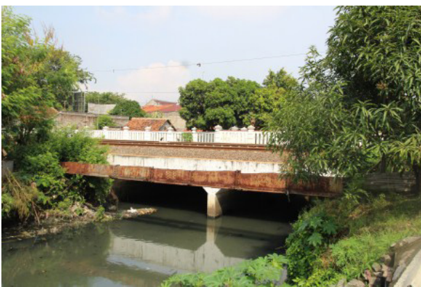
Gambar 4. Struktur Jembatan Sukalila. Jembatan ini sejajar dengan Jembatan Kereta Api Aktif antara Stasiun Cirebon Prujakan dengan Stasiun Cirebon (Kejaksan). (Sumber: Dokumentasi Balar Jawa Barat, 2019)
