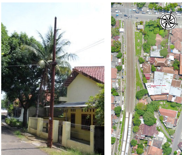
Gambar 2. Railbed Jalur KA Cirebon Pelabuhan: (kiri) Tiang Sinyal Mekanik di Gang Buntu; (kanan) Foto udara Gang Buntu. (Sumber: Dokumentasi Balar Jawa Barat, 2019)
