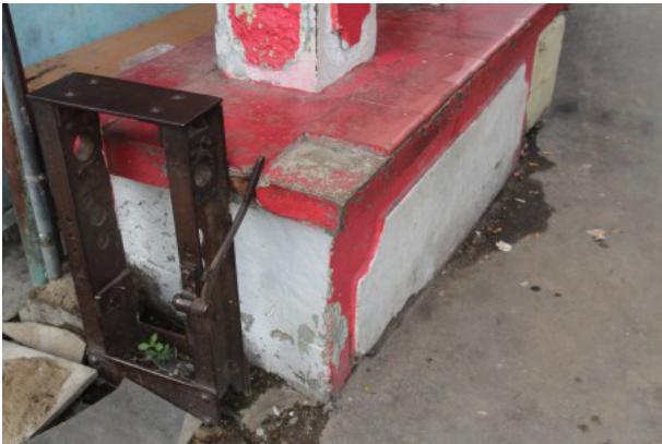
Gambar 6. Struktur Salah satu Tiang Pintu perlintasan Jl. Siliwangi.
