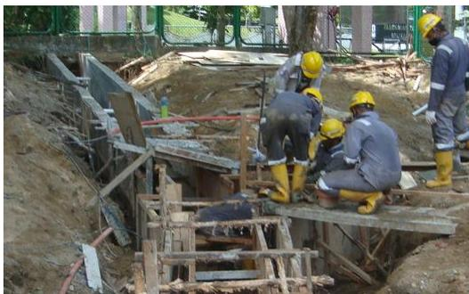
**Gambar 4. Pemasangan saluran U-ditch**
